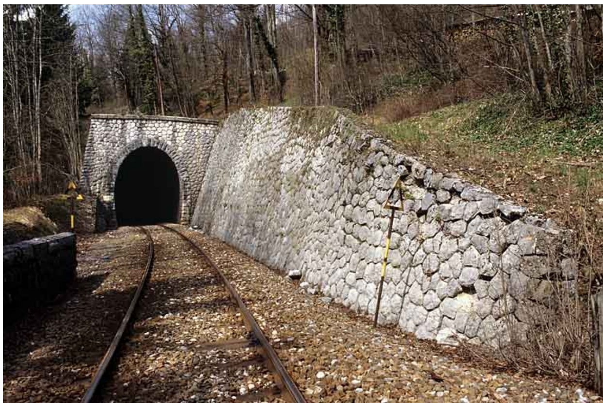
Vue d'ensemble de la tête côté Andelot-en-Montagne.
