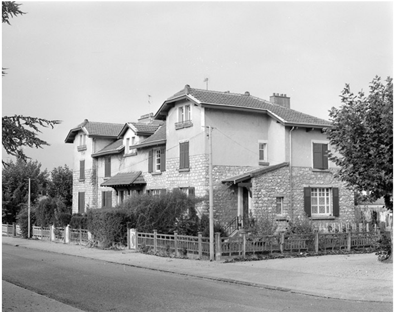
Façade antérieure et face droite.
