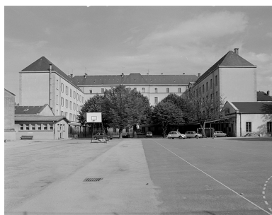
Façades des bâtiments sur la cour. Phot. Yves Sancey IVR43_19833900571X
