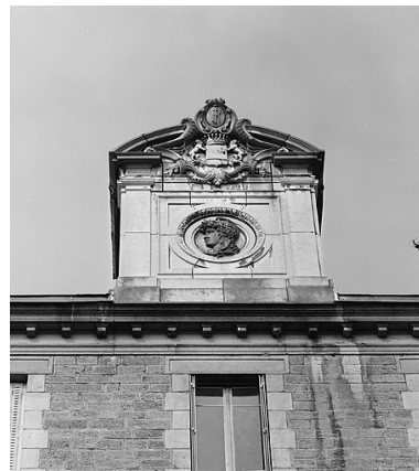
Détail de la façade antérieure. Phot. Yves Sancey IVR43_19833900262X
