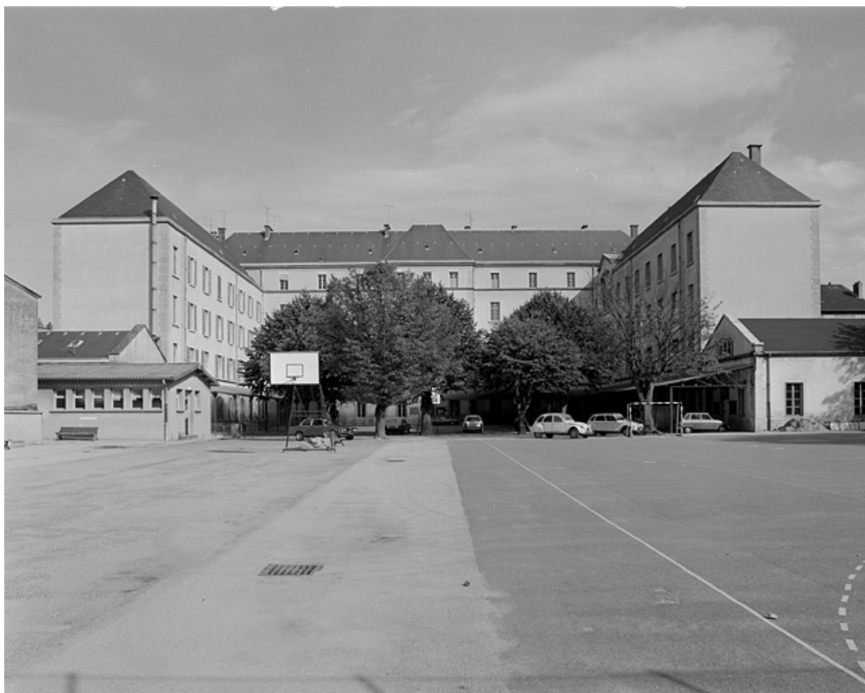
Façades des bâtiments sur la cour.
