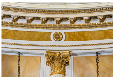
Chapiteau et entablement. Phot. Pierre-Marie Barbe-Richaud IVR26_20257100286NUC4A
