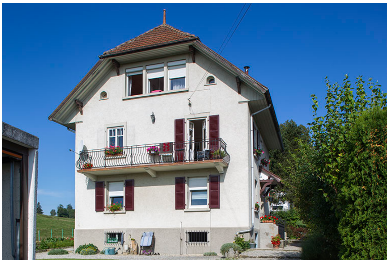
Façade latérale gauche.
