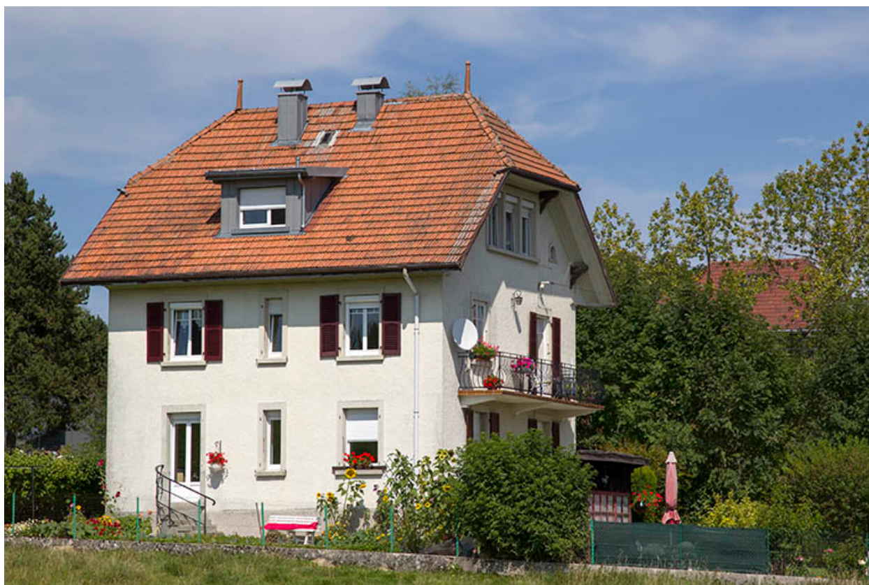
Façades postérieure et latérale gauche.
