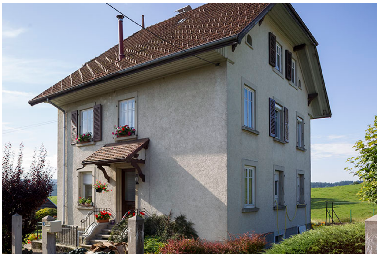
Façades antérieure et latérale droite.
