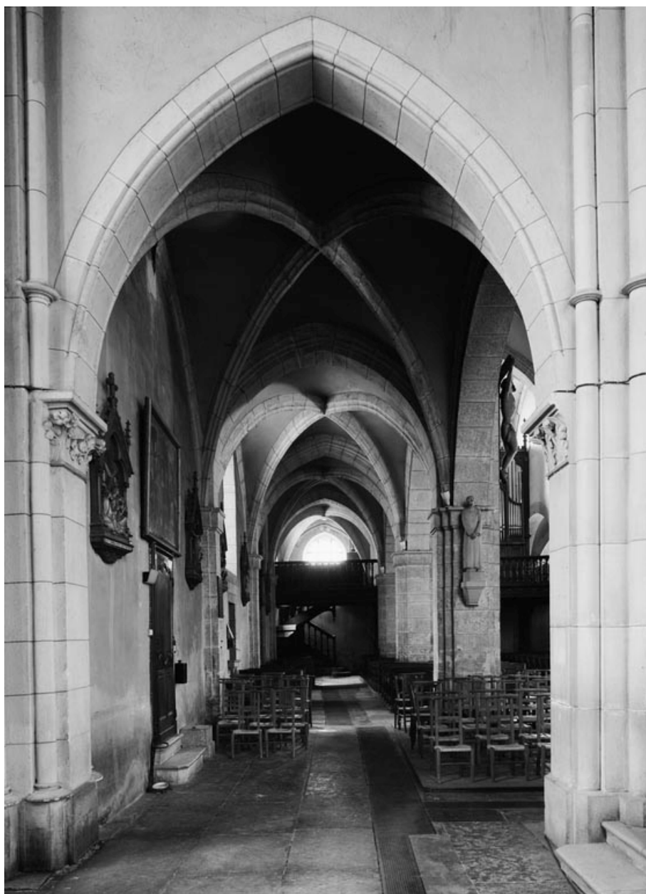
Bas-côté droit, vu depuis le transept.
