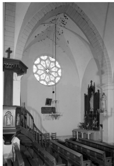
Transept, bras gauche Phot. Michel Thierry IVR26_19852100675V
