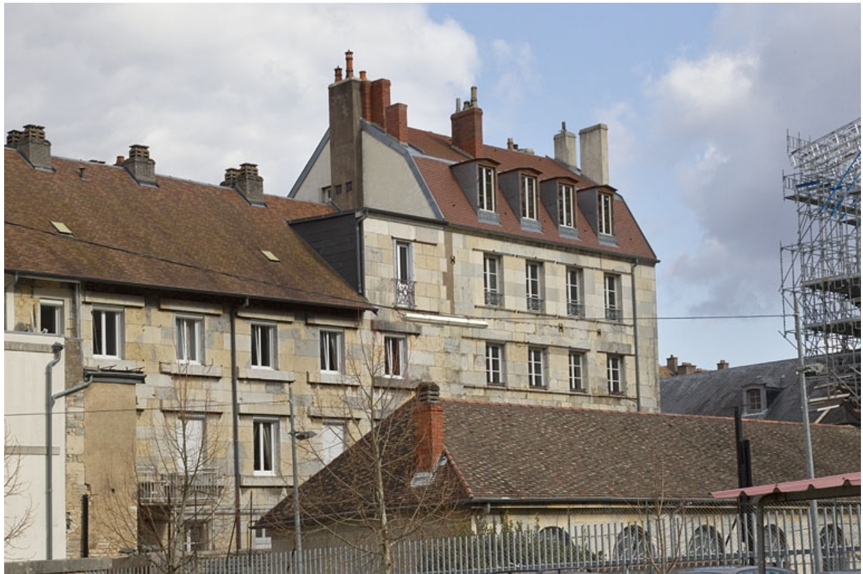
Vue éloignée de l'arrière de l'édifice.
