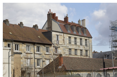
Vue éloignée de l'arrière de l'édifice.
