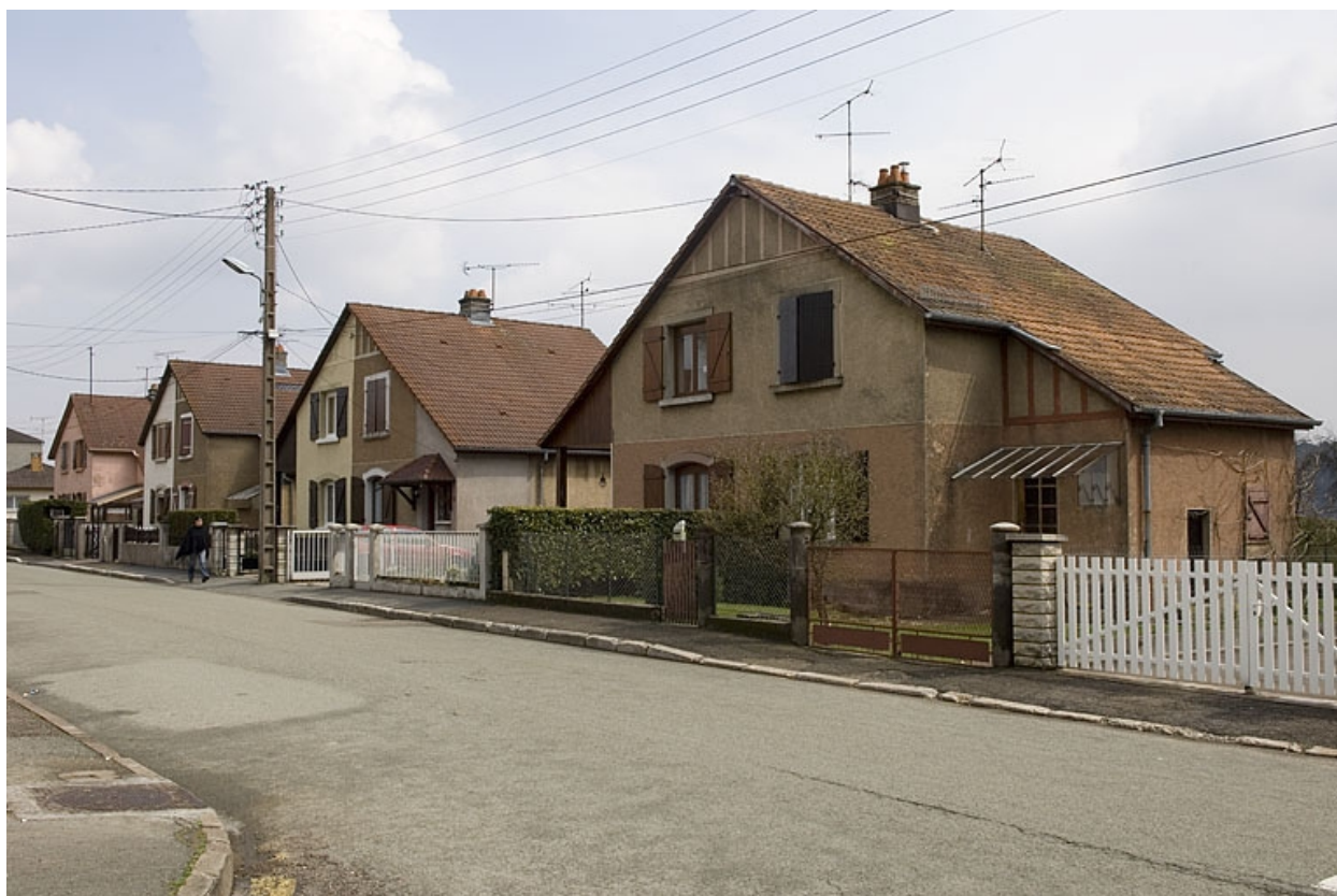
Alignement de quatre maisons (côté pair).
