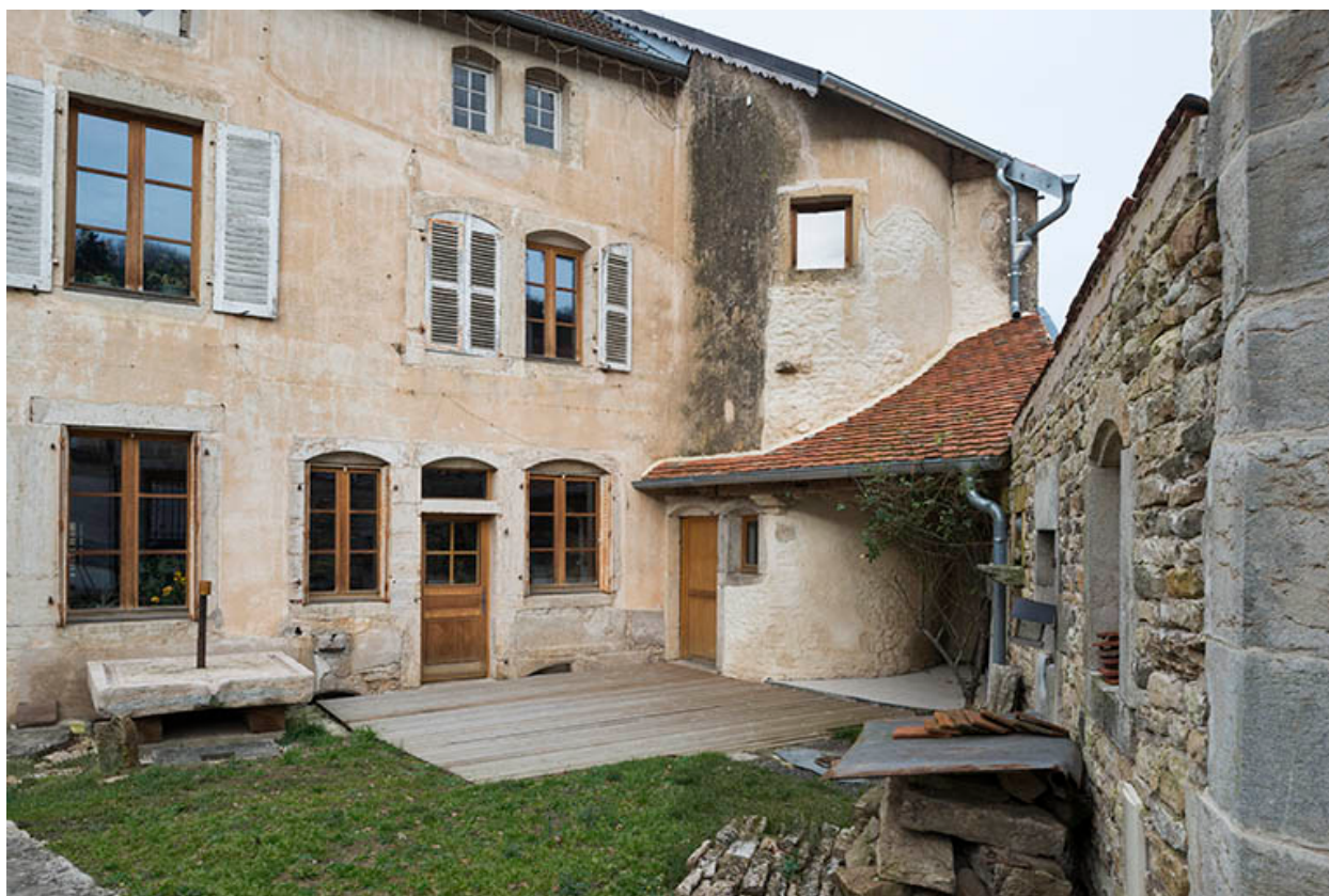
La tour d'escalier, vue extérieure.
