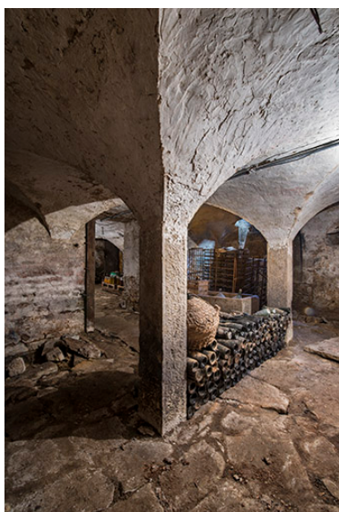
Détail d'une colonne supportant les voûtes. Phot. Jérôme Mongreville IVR43_20187000053NUC4A
