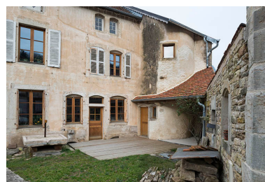
La tour d'escalier, vue extérieure. Phot. Jérôme Mongreville IVR43_20187000045NUC4A
