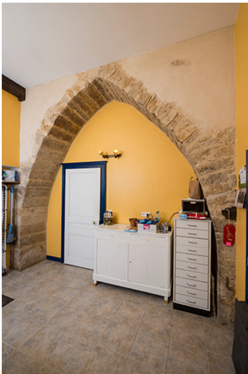
Voûte en tiers-point, arrière cuisine.
