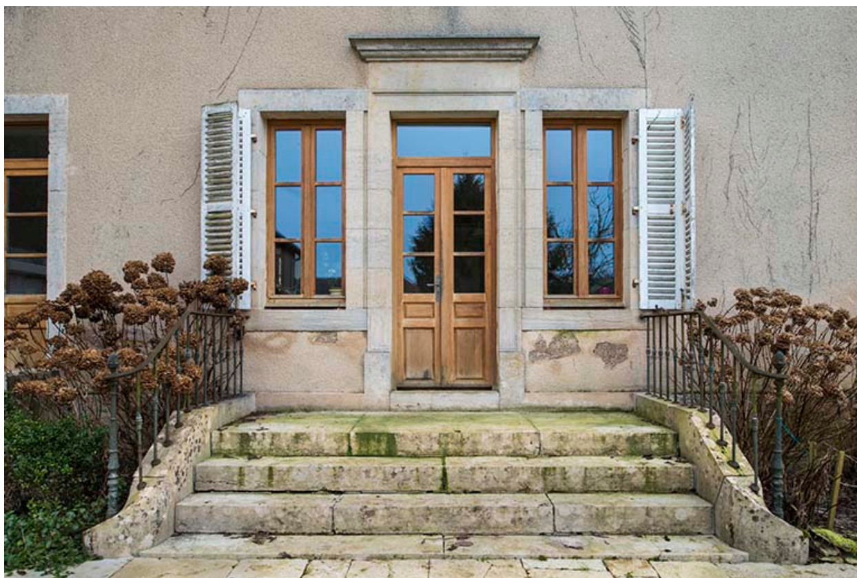
Détail de la façade postérieure.
