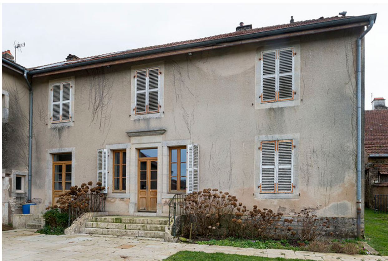
Façade postérieure, vue générale.
