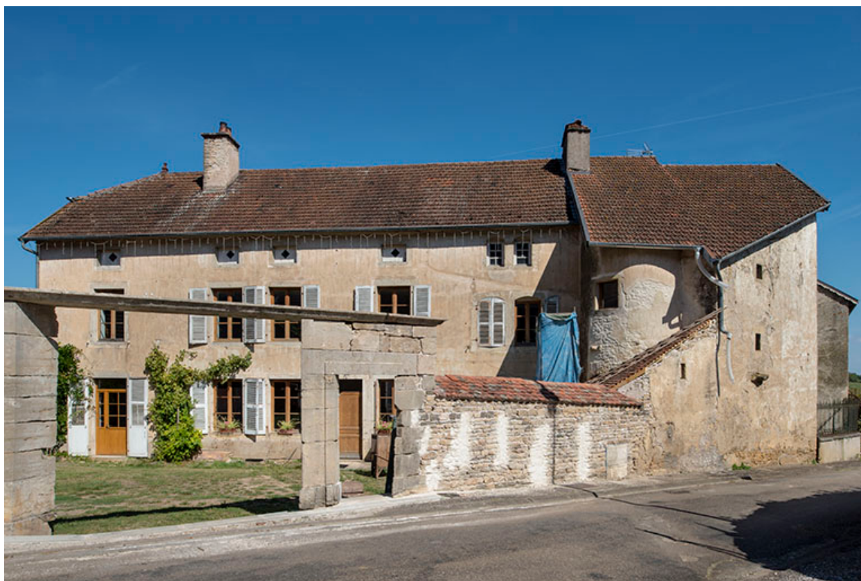
La façade antérieure depuis la rue.
