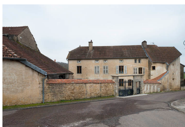
Vue générale. Phot. Jérôme Mongreville IVR43_20187000040NUC4A
