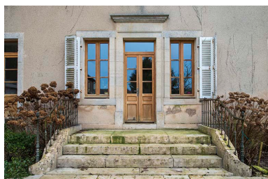
Détail de la façade postérieure. Phot. Jérôme Mongreville IVR43_20187000049NUC4A
