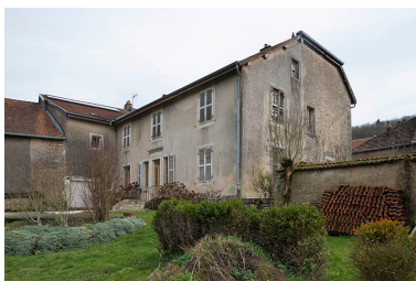
Vue de trois-quarts depuis le jardin. Phot. Jérôme Mongreville IVR43_20187000047NUC4A
