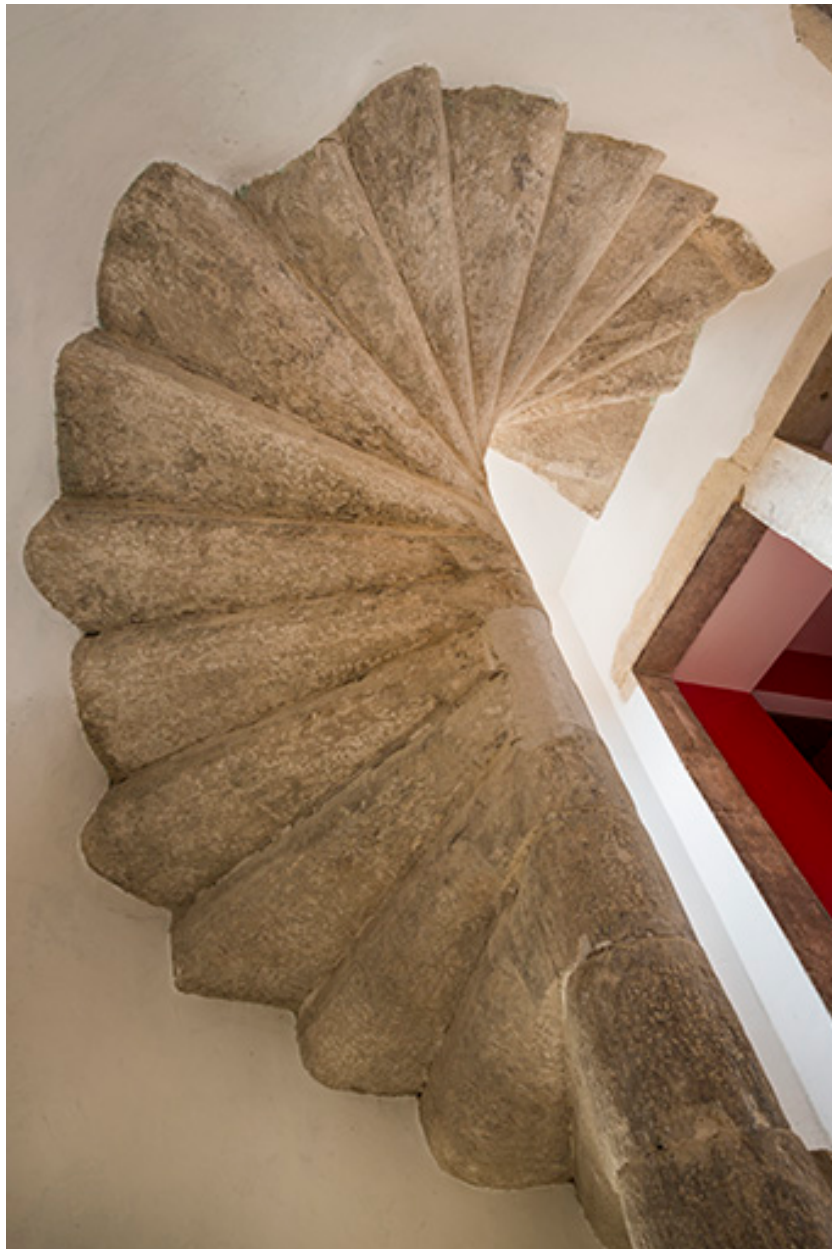
Vue en contre-plongée de l'escalier.
