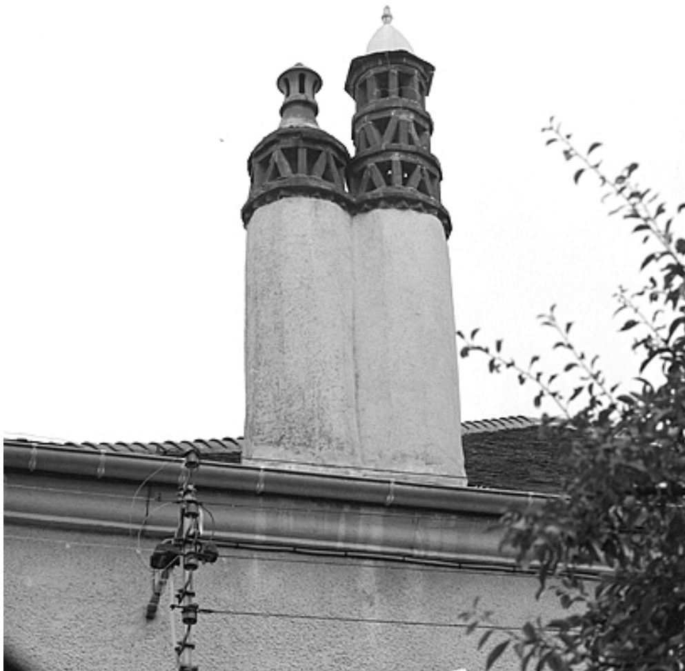
Souches de cheminée.
