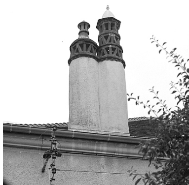
Souches de cheminée. Phot. Yves Sancey IVR43_19833900150X
