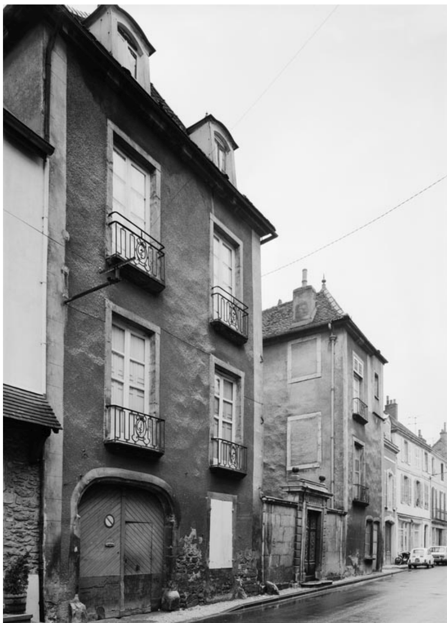
Façade principale, vue de 3/4 gauche.
