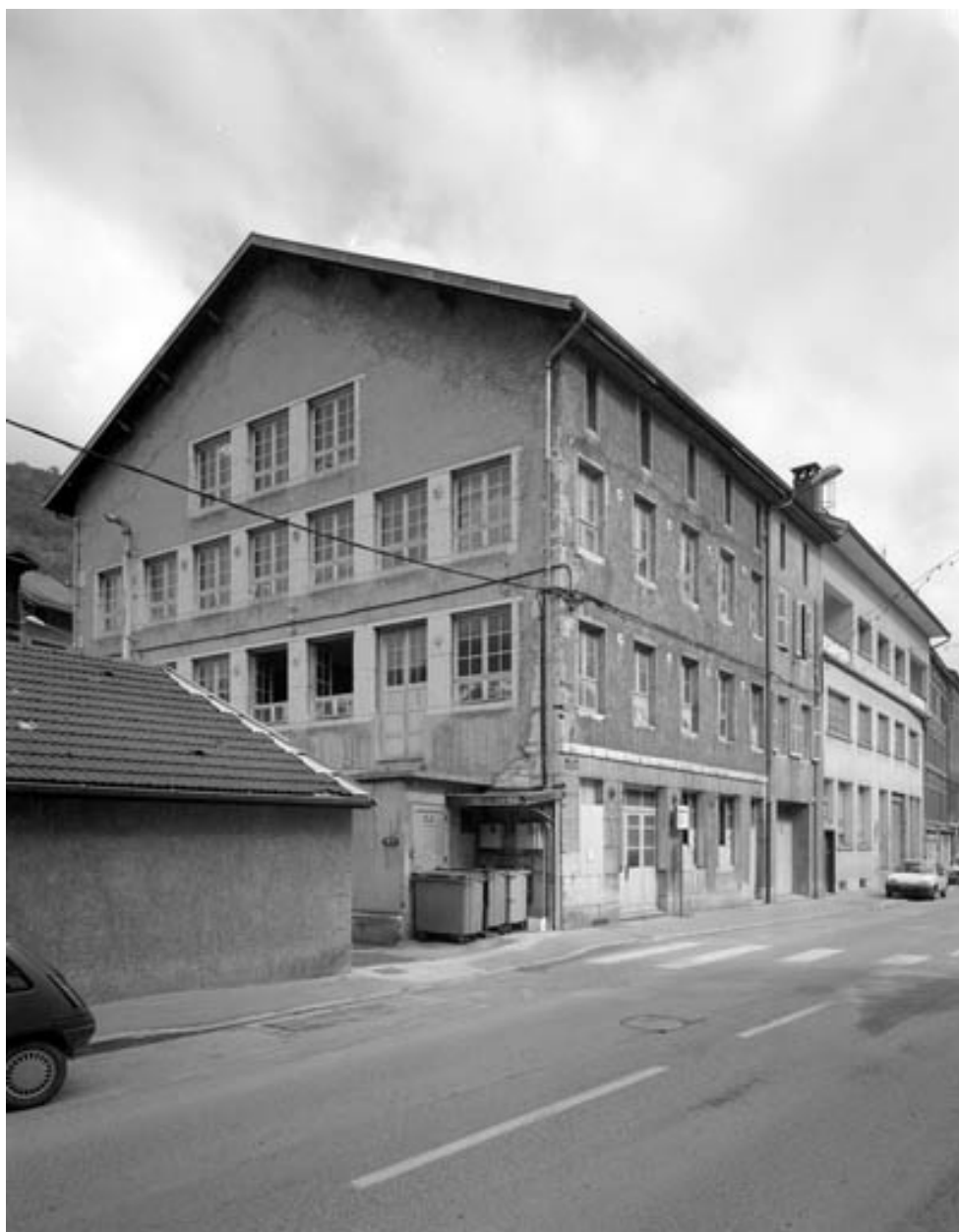
Atelier de fabrication au n° 16.
