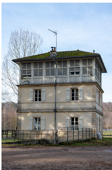
Façade sud-ouest et façade nord-ouest.
