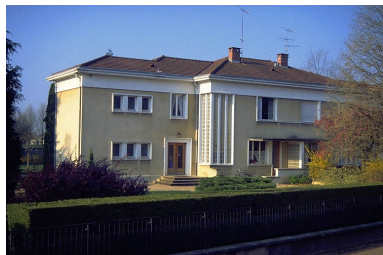
Façade antérieure. Phot. Laurent Poupard IVR43_19893900524ZA
