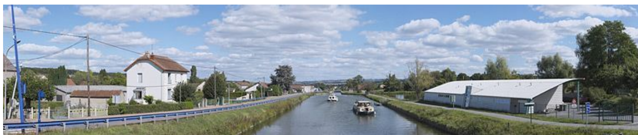
Echelle d'écluses depuis le pont sur l'écluse 01.
