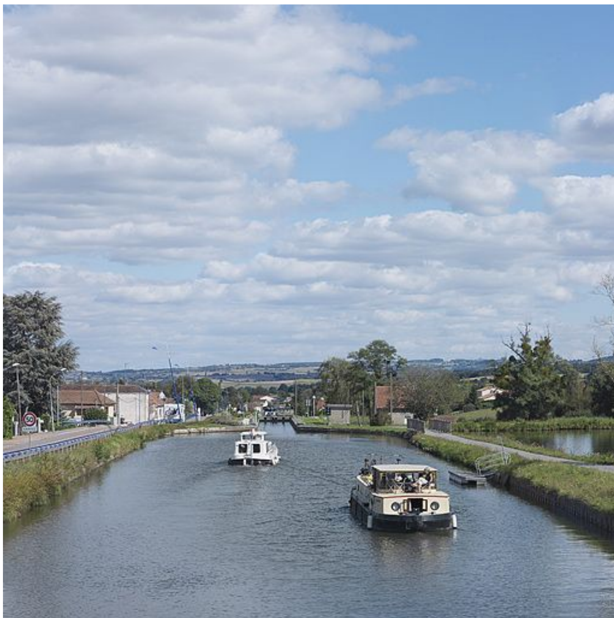
Echelle d'écluses depuis le pont sur l'écluse 01.
