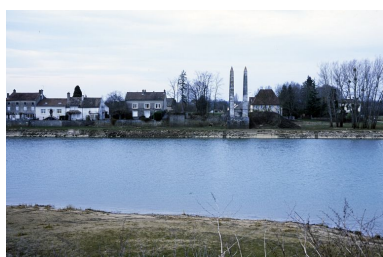
Pylônes, vestiges du pont suspendu en 2003. Phot. Michel Rosso IVR26_20037100104ZA
