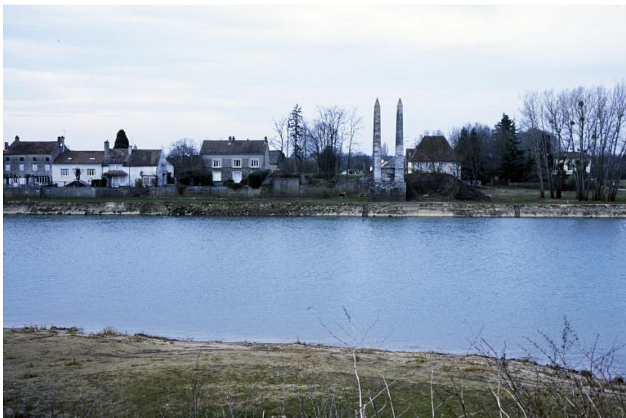
Pylônes, vestiges du pont suspendu en 2003.
