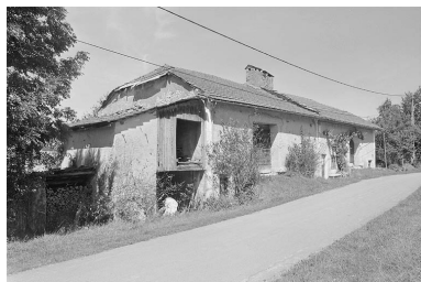
Fermes sur la commune de Ponthoux. Phot. Jérôme Mongreville IVR43_19963901036X
