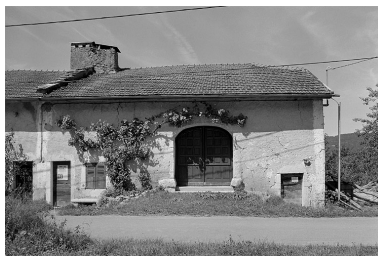
Façade antérieure d'une ferme. Phot. Jérôme Mongreville IVR43_19963901038X
