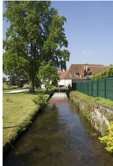
Bief d'amenée. Phot. Jérôme Mongreville IVR43_20077000179NUCA
