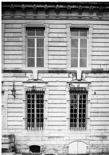
Façade, détail. Phot. Michel Rosso IVR26_19862100096V
