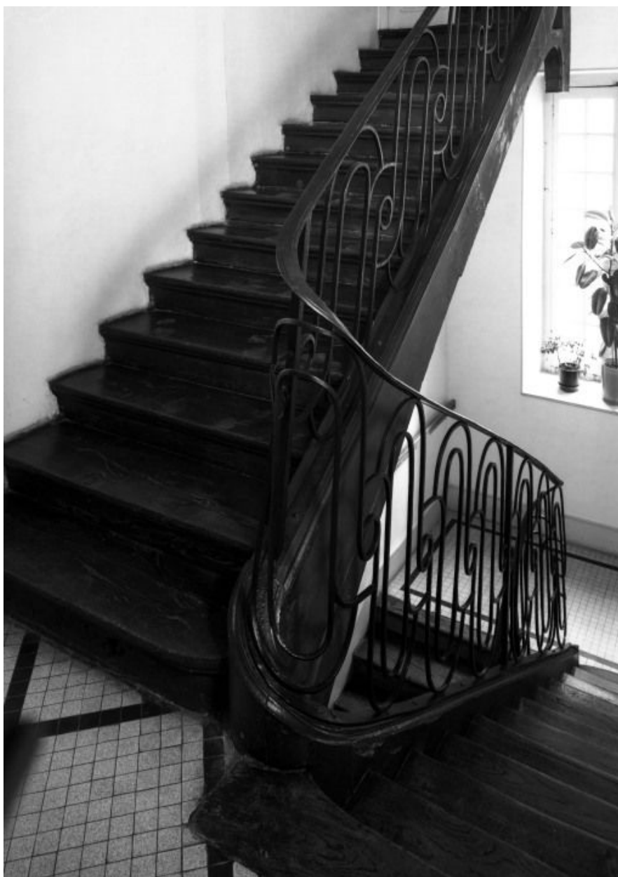
Escalier, deuxième et troisième volées.
