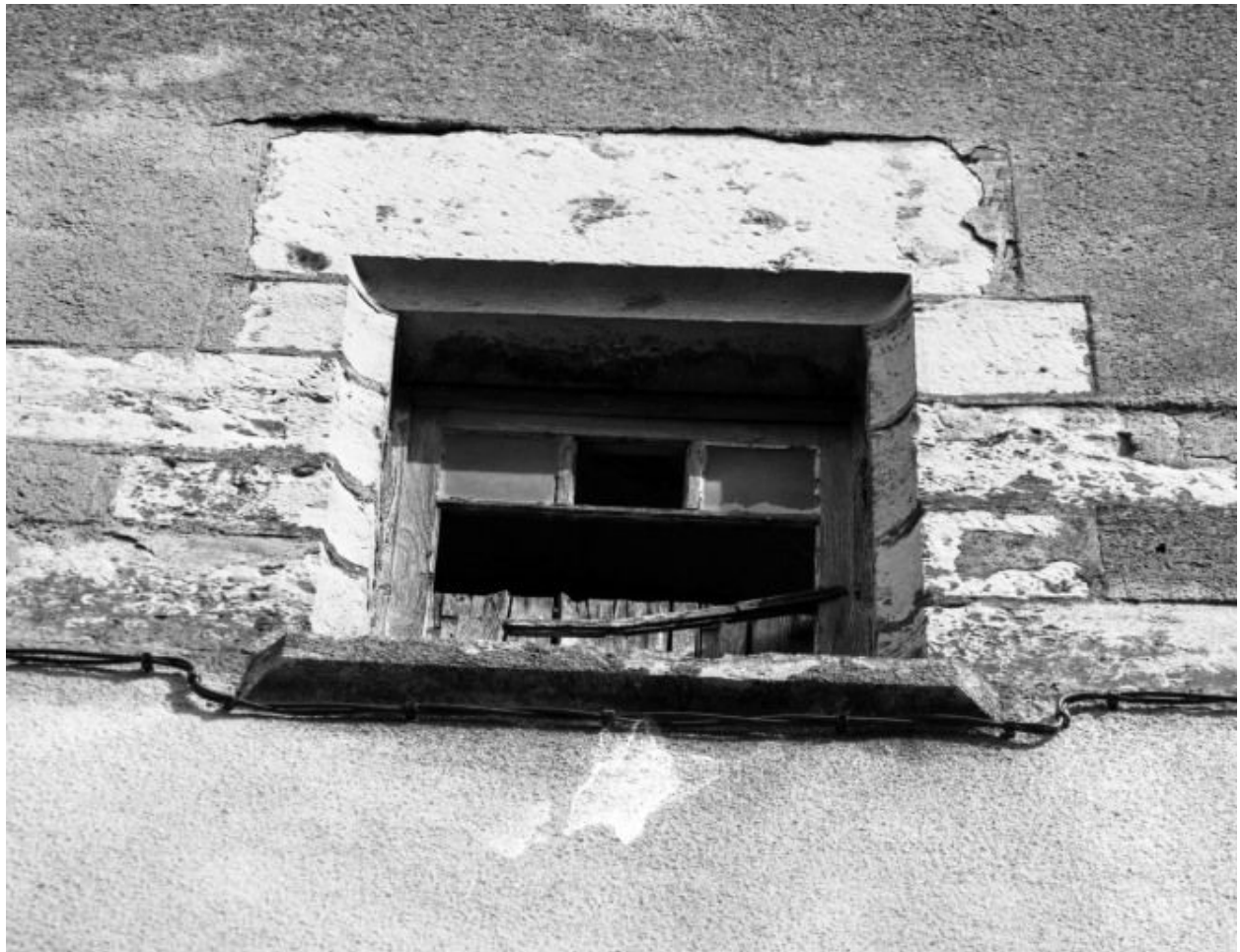
Détail : baie du pignon gauche.
