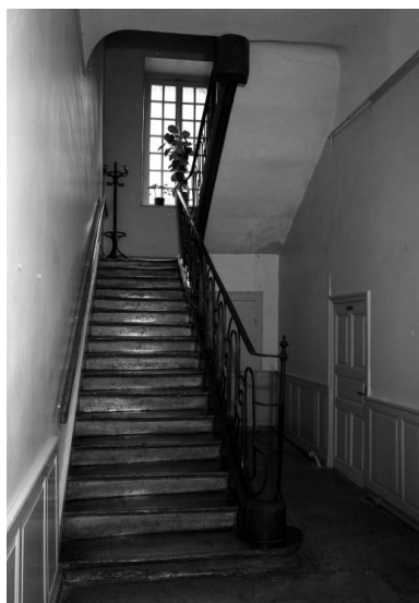
Escalier, première volée. Phot. Michel Rosso IVR26_19862100102V
