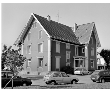
Le logement patronal depuis le nord. Phot. Yves Sancey IVR43_19999000036X
