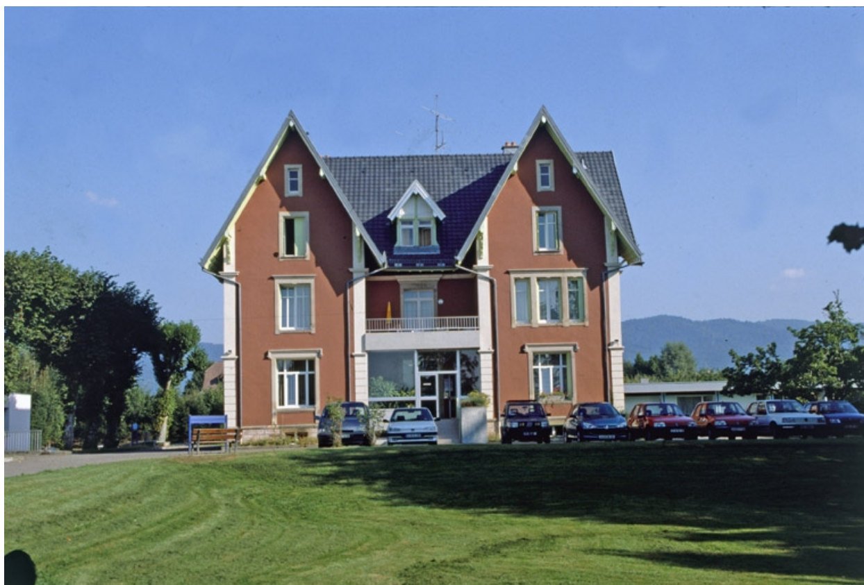
Façade sud-est du logement patronal.
