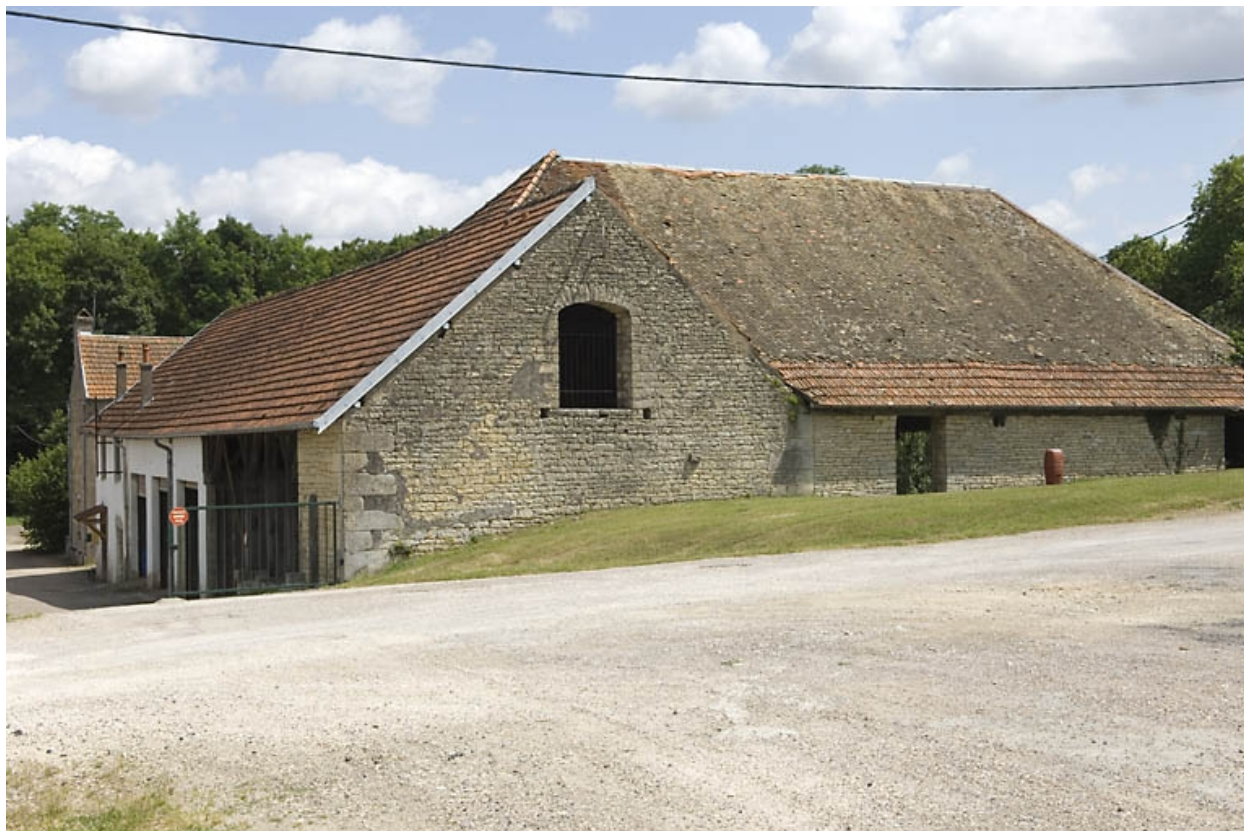
Halle à charbon depuis le sud-est.
