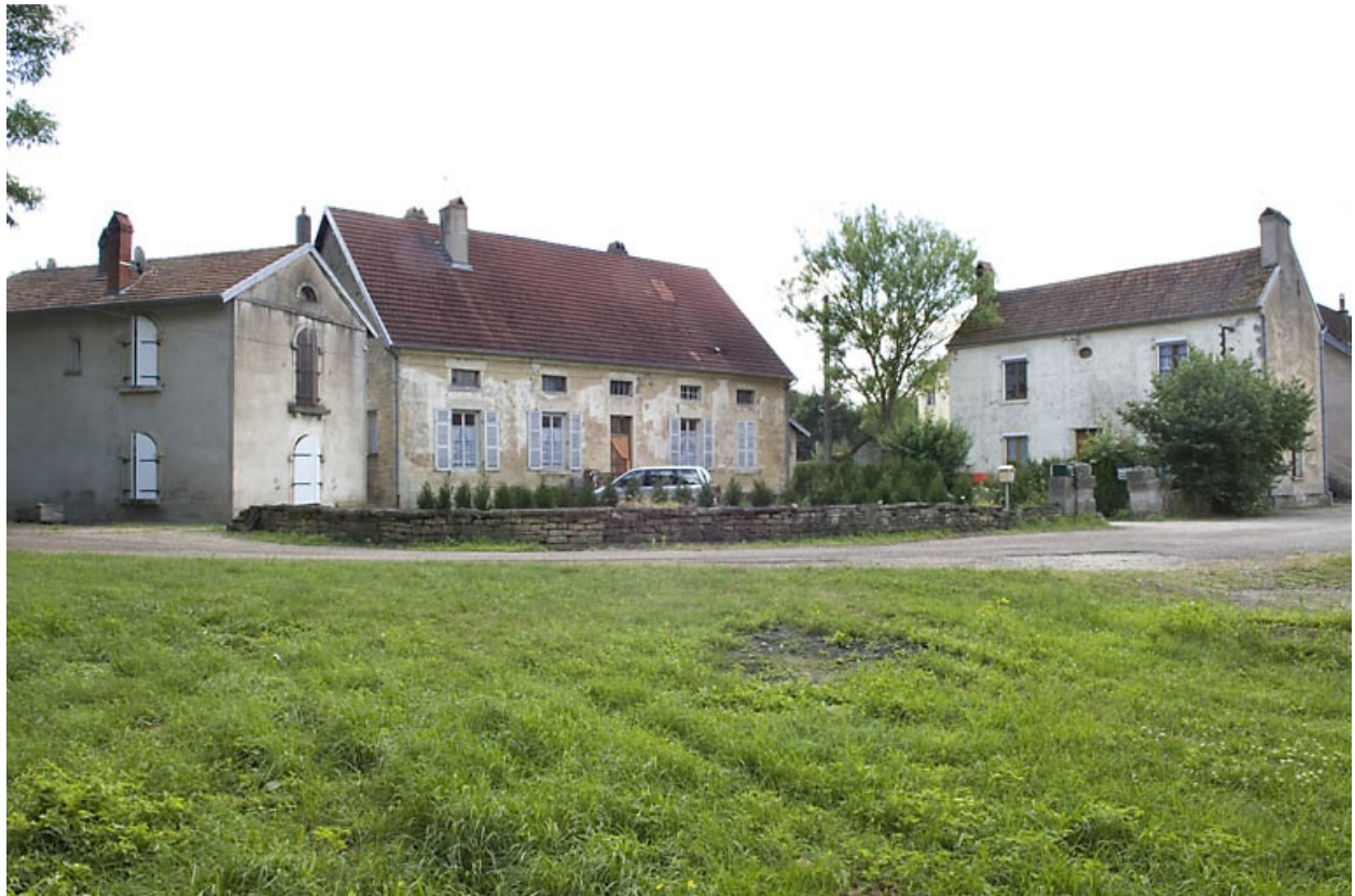
Bureau (?) et logements.
