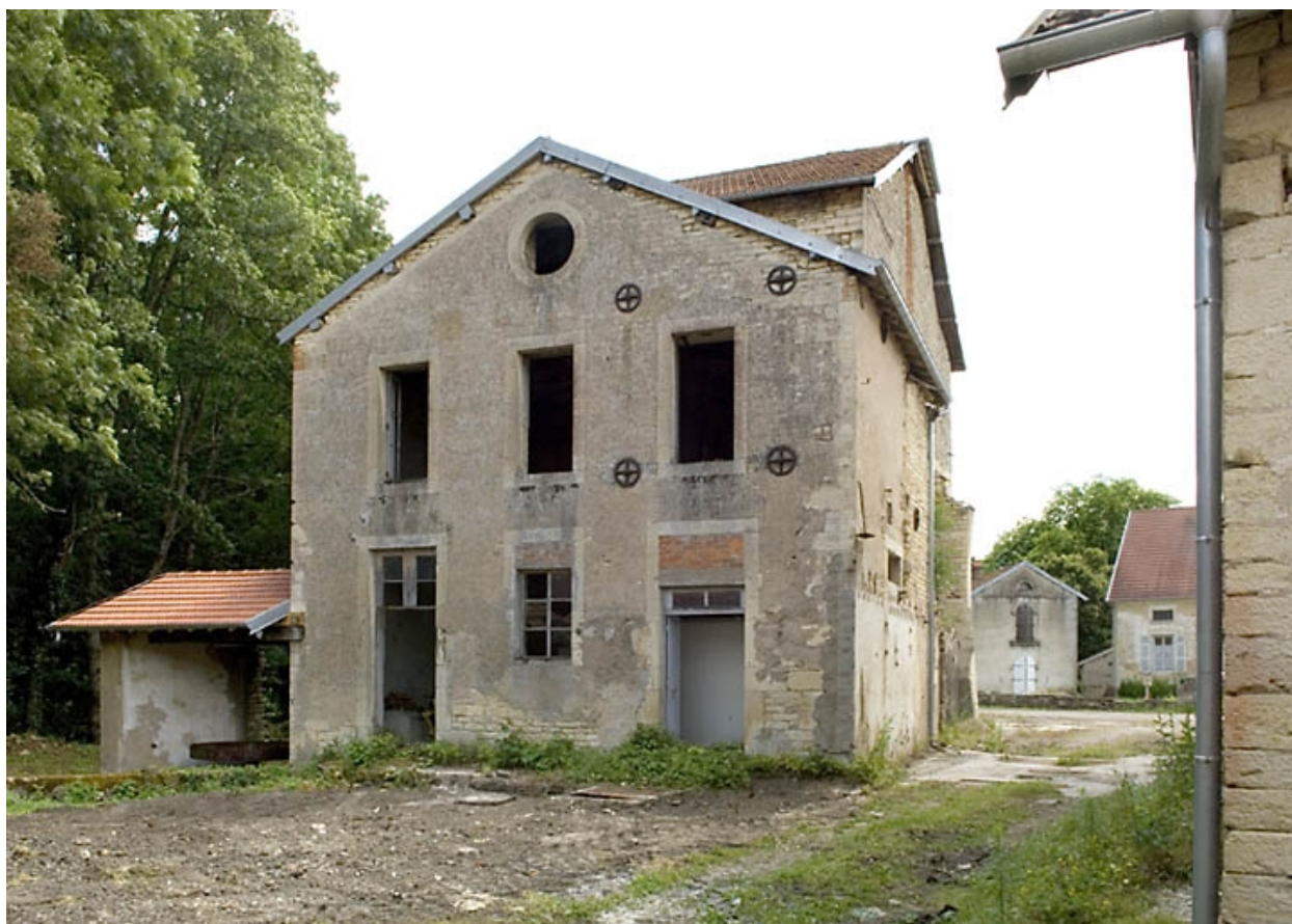
Façade ouest du haut fourneau.
