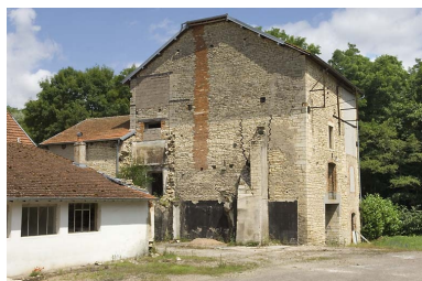
Le haut fourneau vu depuis le sud. Phot. Jérôme Mongreville IVR43_20087000701NUC2A
