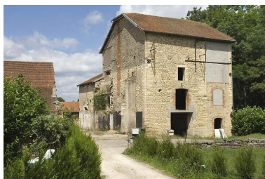
Le haut fourneau vu depuis le sud-ouest. Phot. Jérôme Mongreville IVR43_20087000703NUC2A
