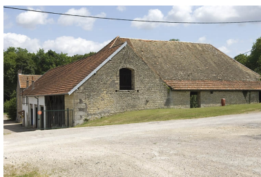
Halle à charbon depuis le sud-est. Phot. Jérôme Mongreville IVR43_20087000708NUC2A
