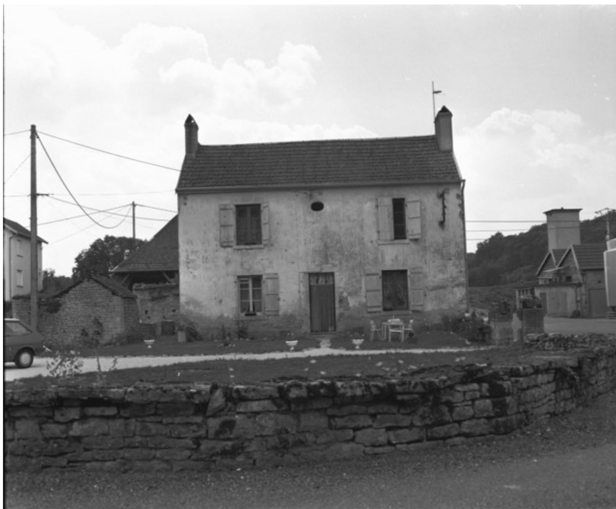
Logement. Vue de face en 1989.
