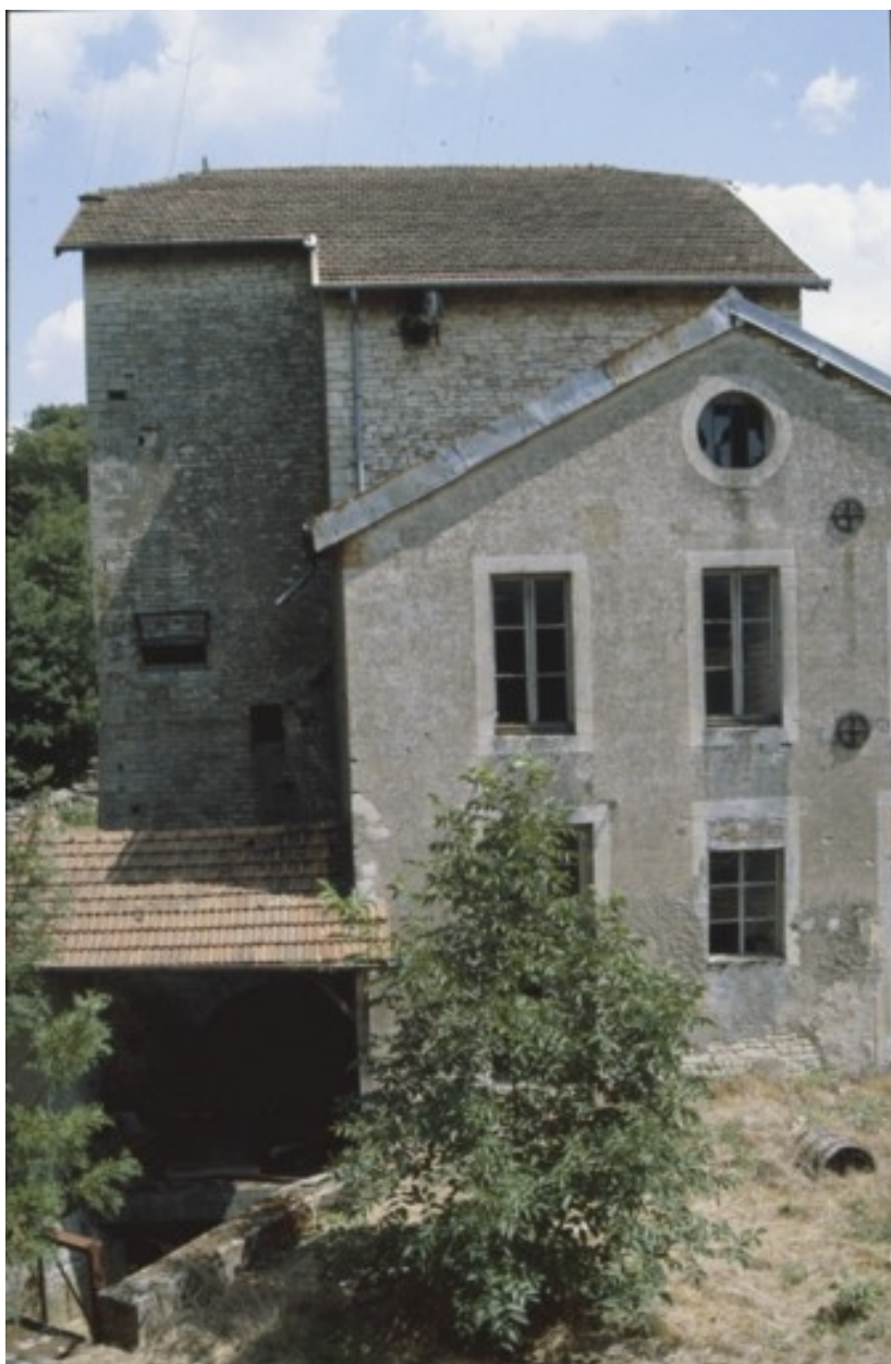
Façade postérieure du haut fourneau en 1989.
