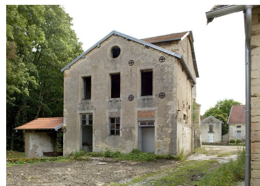
Façade ouest du haut fourneau. Phot. Jérôme Mongreville IVR43_20087000707NUC2A
