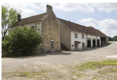
Logement et halle à charbon (remaniée). Phot. Jérôme Mongreville IVR43_20087000706NUC2A
