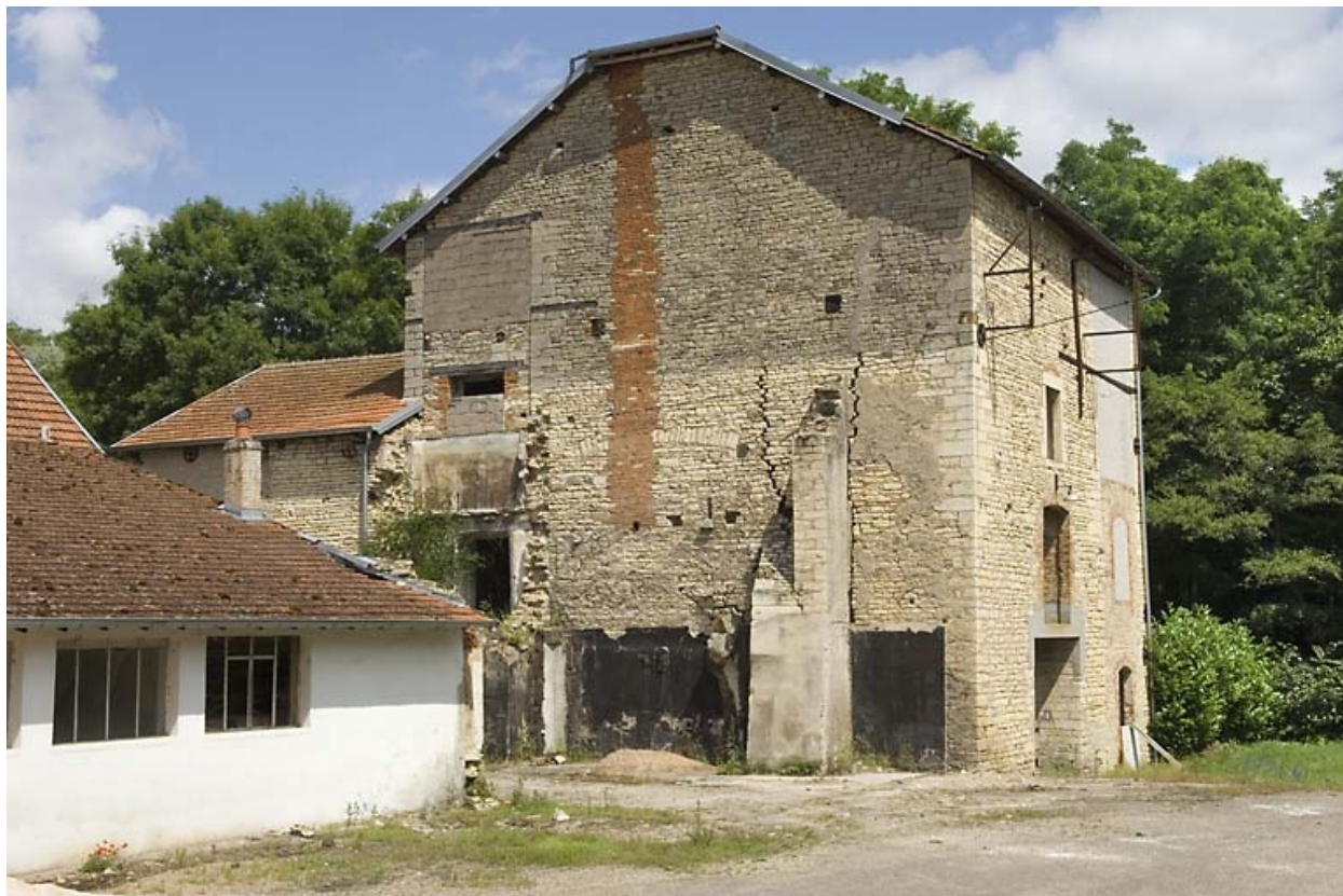
Le haut fourneau vu depuis le sud.
