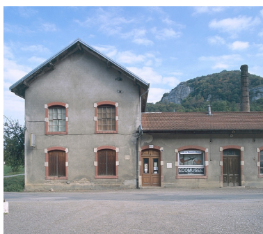
Façade antérieure du bâtiment à étage.
