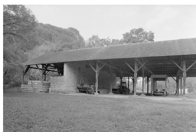
L'entrepôt à merisier.
