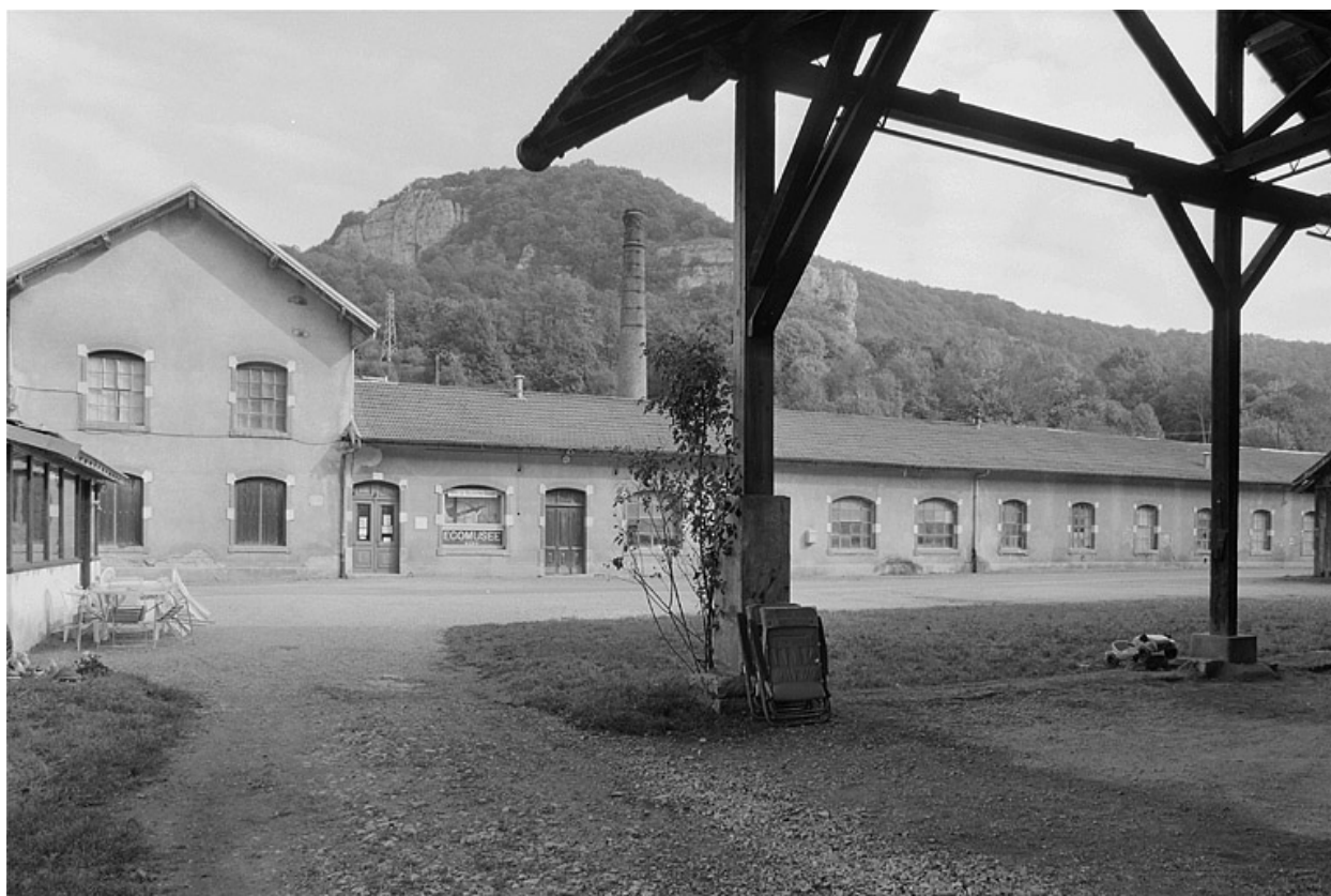
Façade antérieure depuis le sud.
