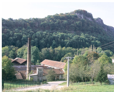
Vue des toitures depuis le nord. Phot. Yves Sancey IVR43_20022500711XA
