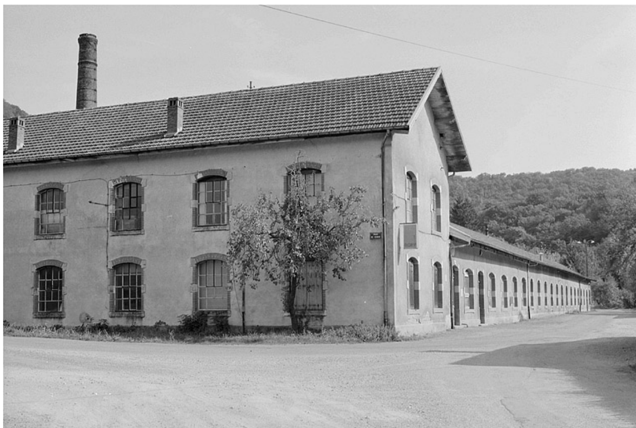
Façade antérieure depuis l'ouest.
