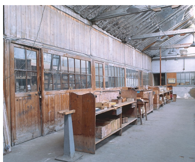
Baies vitrées de divers ateliers (vérification, préparation
