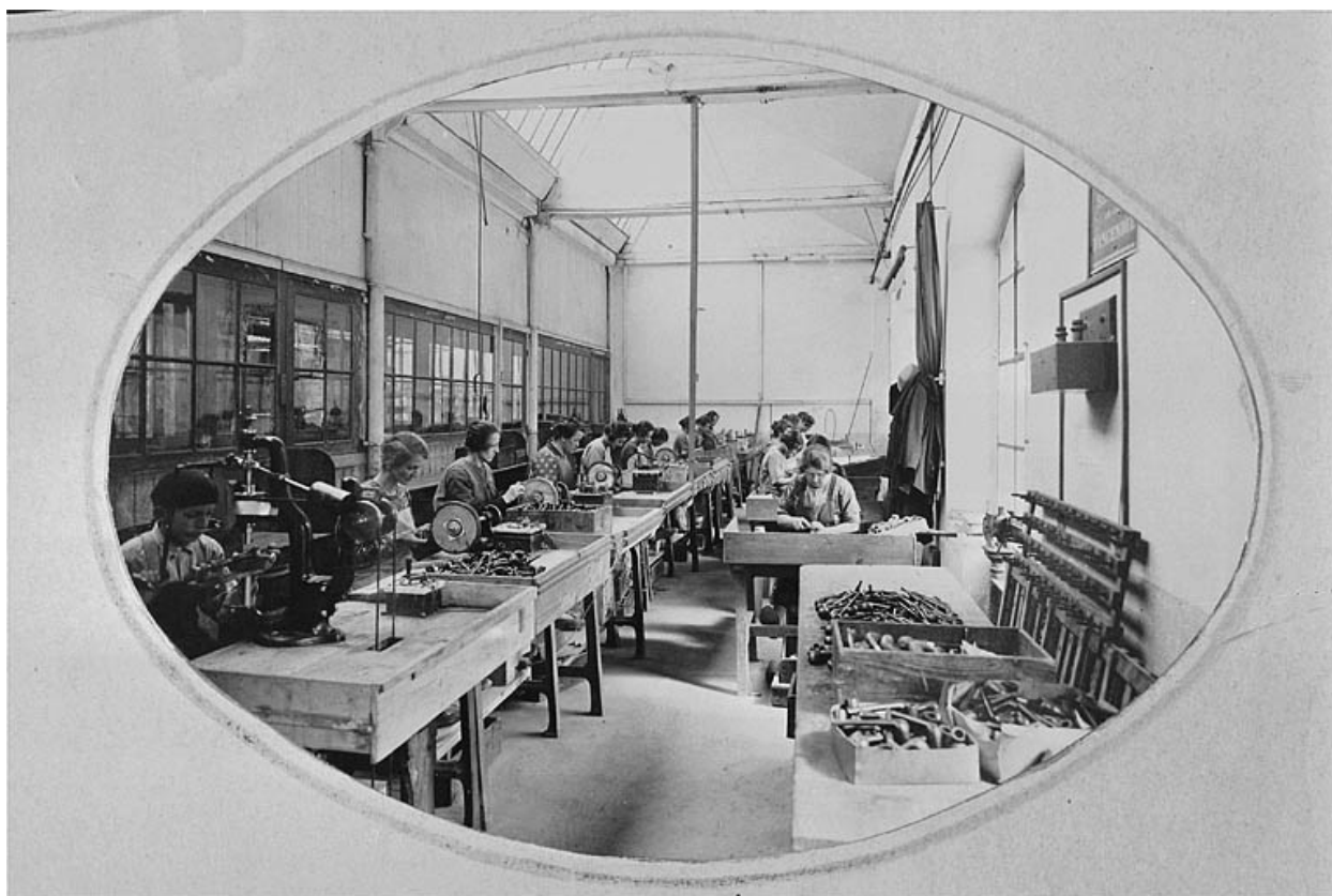
Vue intérieure de l'atelier de finissage des pipes (dit les Anglaises).
