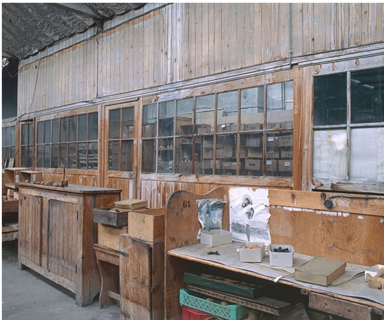
Cloison vitrée d'un atelier de vérification.
