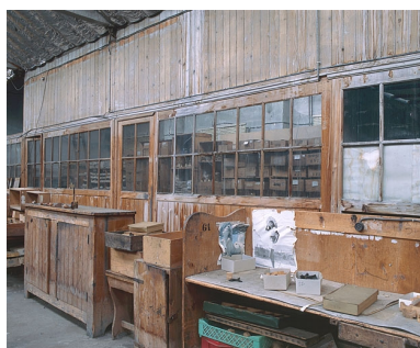
Cloison vitrée d'un atelier de vérification. Phot. Jérôme Mongreville IVR43_20022500651XA
