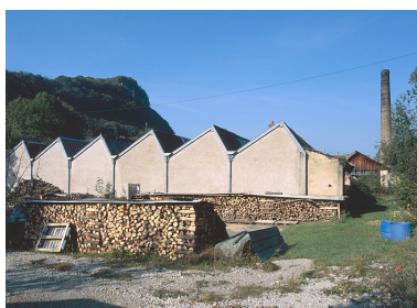
Murs-pignons est de l'atelier de fabrication. Phot. Yves Sancey IVR43_20022500680XA
