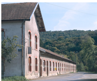
Alignement de la façade antérieure.
