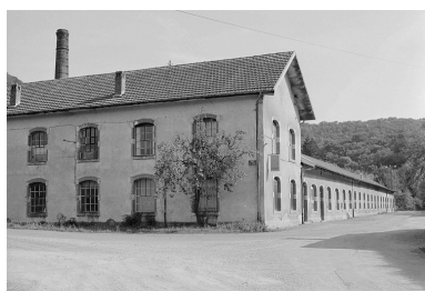
Façade antérieure depuis l'ouest.
