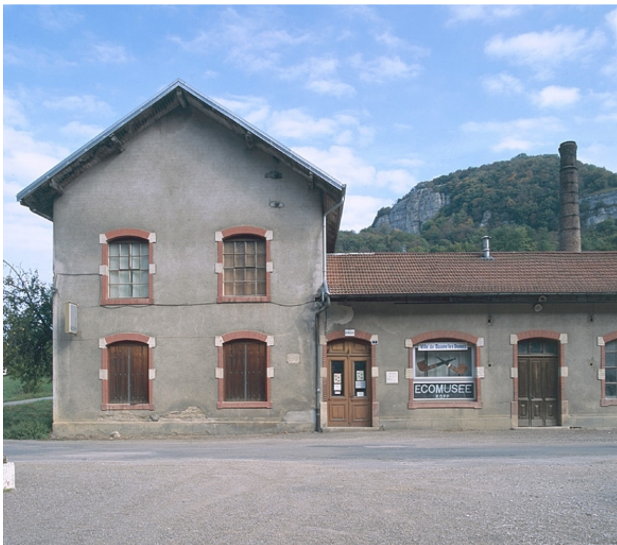
Façade antérieure du bâtiment à étage.
