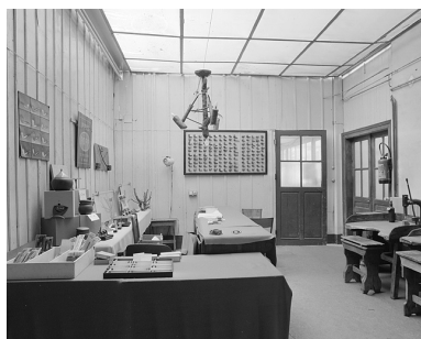
Hall (ancienne boutique). Phot. Yves Sancey IVR43_20022500788X
