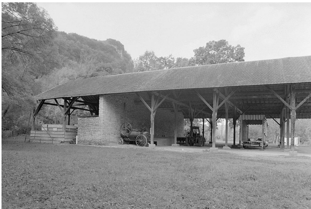
L'entrepôt à merisier.
