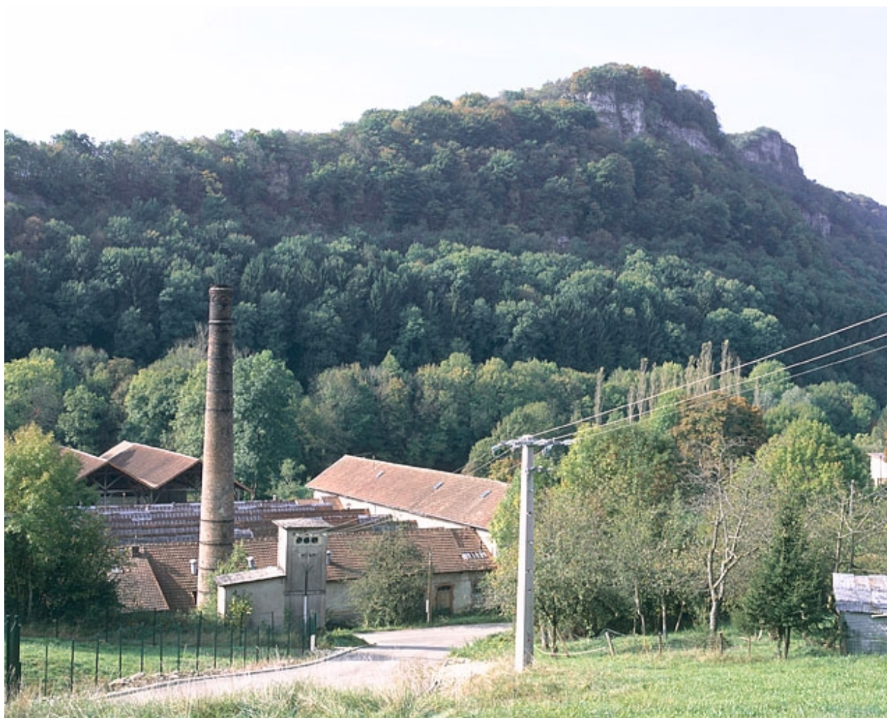
Vue des toitures depuis le nord.
