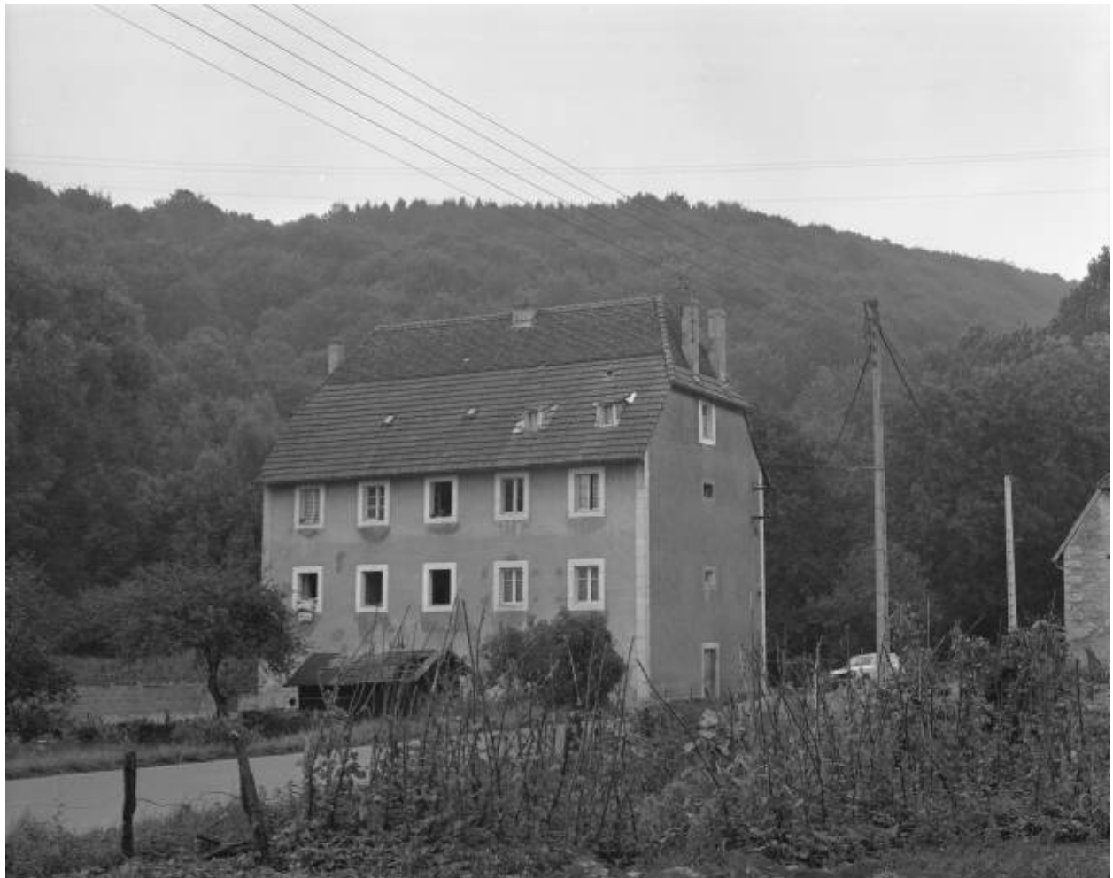
Logement ouvrier vu de trois quarts en 1981.
