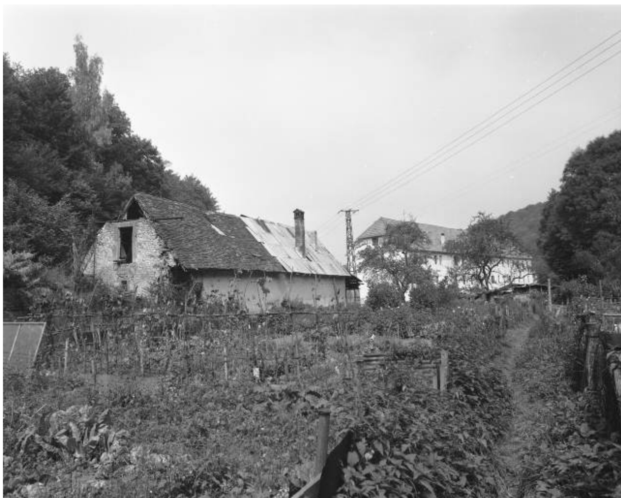
Magasin industriel situé derrière la filature en 1981.
