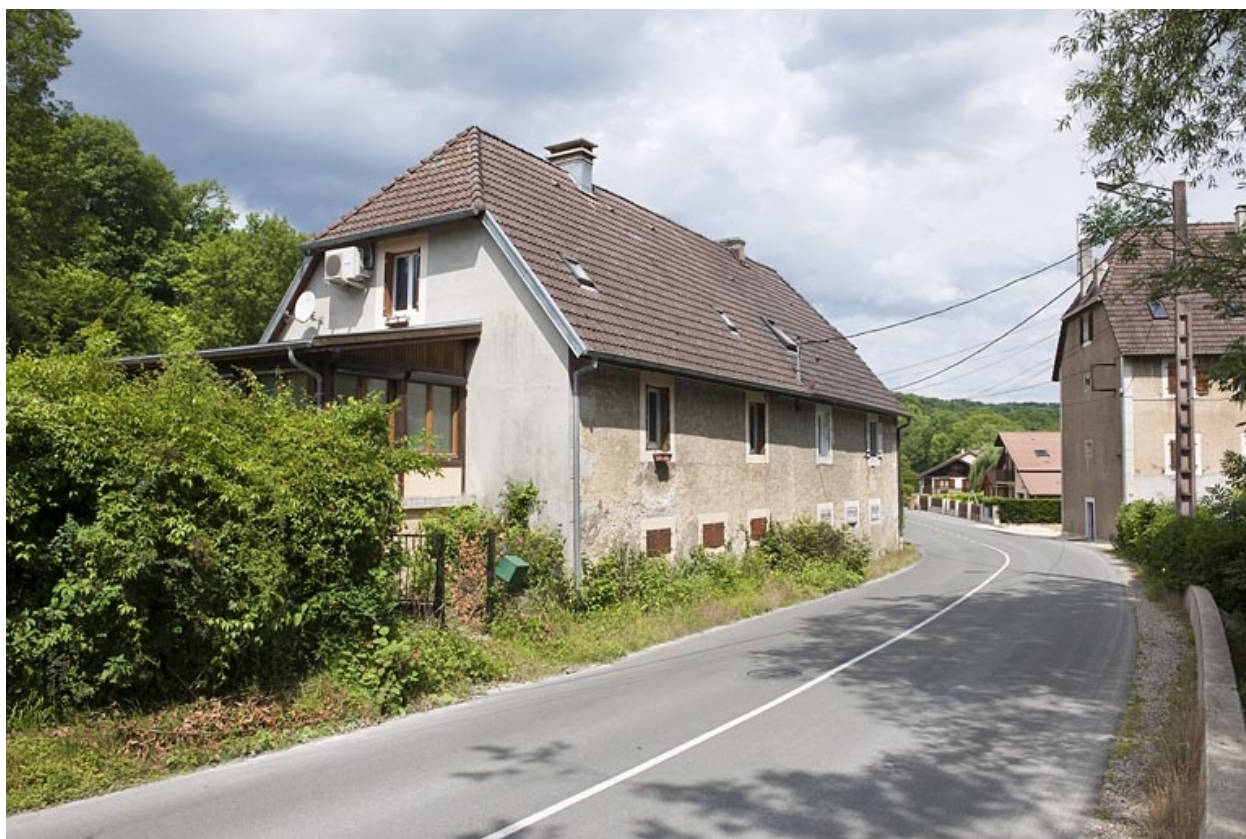
Logement d'ouvriers depuis le sud.
