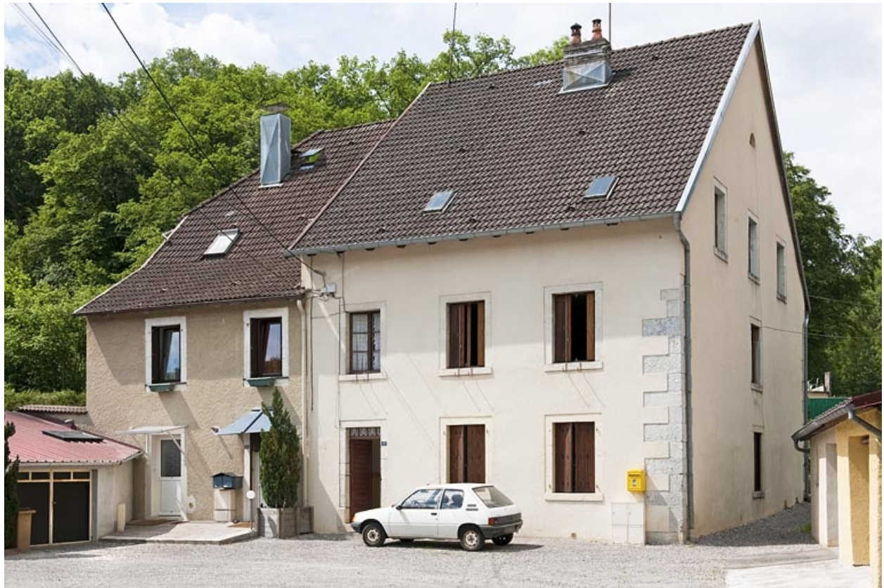
Bureau et logement du directeur.
