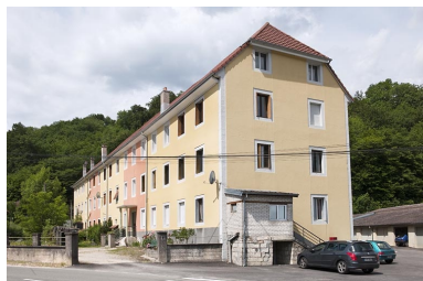
Façade sud vue de trois quarts. Phot. Jérôme Mongreville IVR43_20112501305NUC4A
