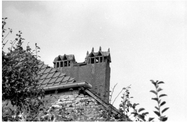
Les cheminées. Phot. Bernard Lardière IVR43_19797000066Z
