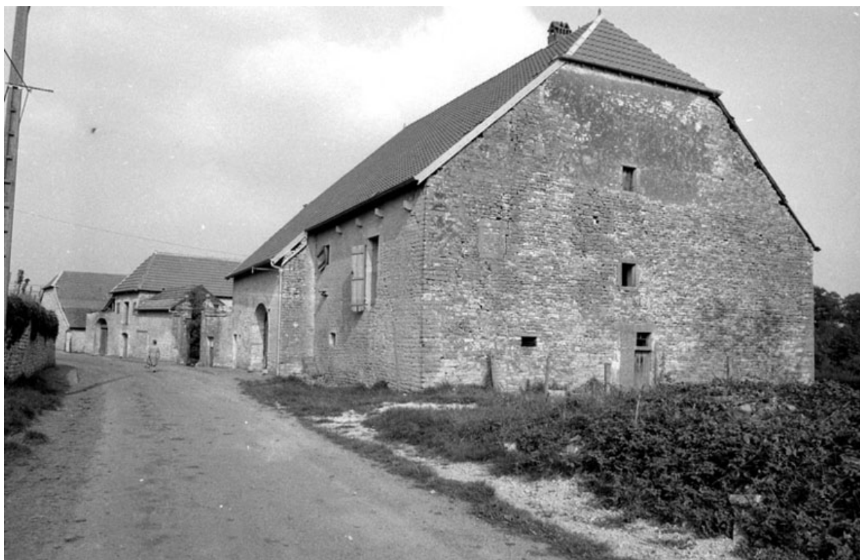
Façade antérieure et latérale droite.
