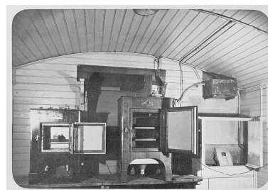
[Installation pour les tests thermiques et d'étanchéité, au sous-sol de la chronométrie], limite 19e siècle 20e siècle. Phot. Yves Sancey IVR43_20042500152X
