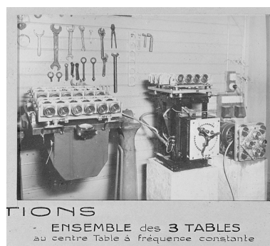
Essais de vibrations. Ensemble de 3 tables. Au centre table à fréquence constante, entre 1932 et 1934. Phot. Yves Sancey IVR43_20022501247X
