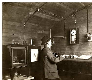
[Etuve de Kearson et contrôle des montres, au sous-sol du service chronométrique], 1er quart 20e siècle. Phot. Yves Sancey IVR43_20052500023NUCA
