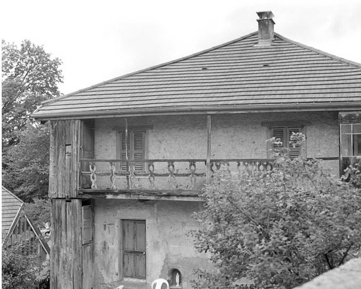
Balcon en galerie sur la façade antérieure.
