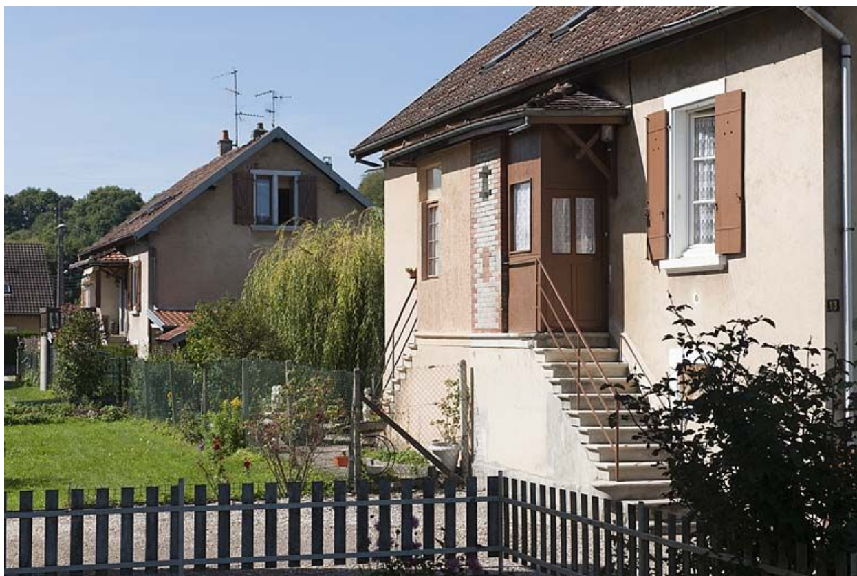
Maisons jumelées. Vue de trois quarts.
