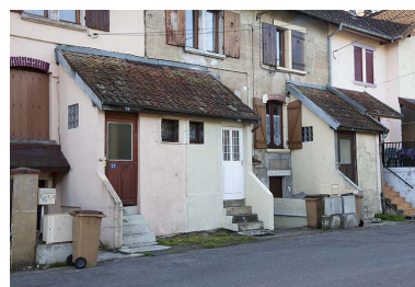
Immeuble de 8 logements. Les entrées. Phot. Jérôme Mongreville IVR43_20112502413NUC4A
