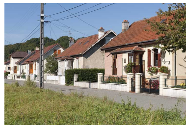
Maisons jumelées rue de Champagne. Phot. Jérôme Mongreville IVR43_20112502400NUC4A
