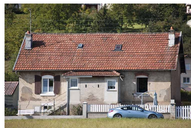
Maison jumelée rue de Champagne. Façade sud. Phot. Jérôme Mongreville IVR43_20112502412NUC4A
