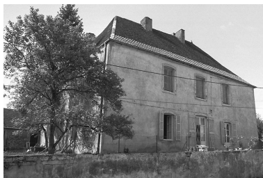
Maison située route de Valay. Phot. Bernard Lardière IVR43_19817000418Z
