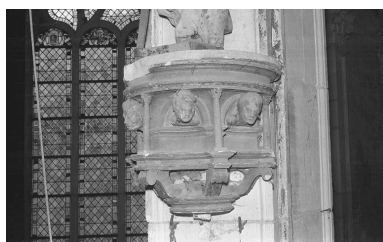
2ème pilier du rond-point, console. IVR26_19728900569Z
