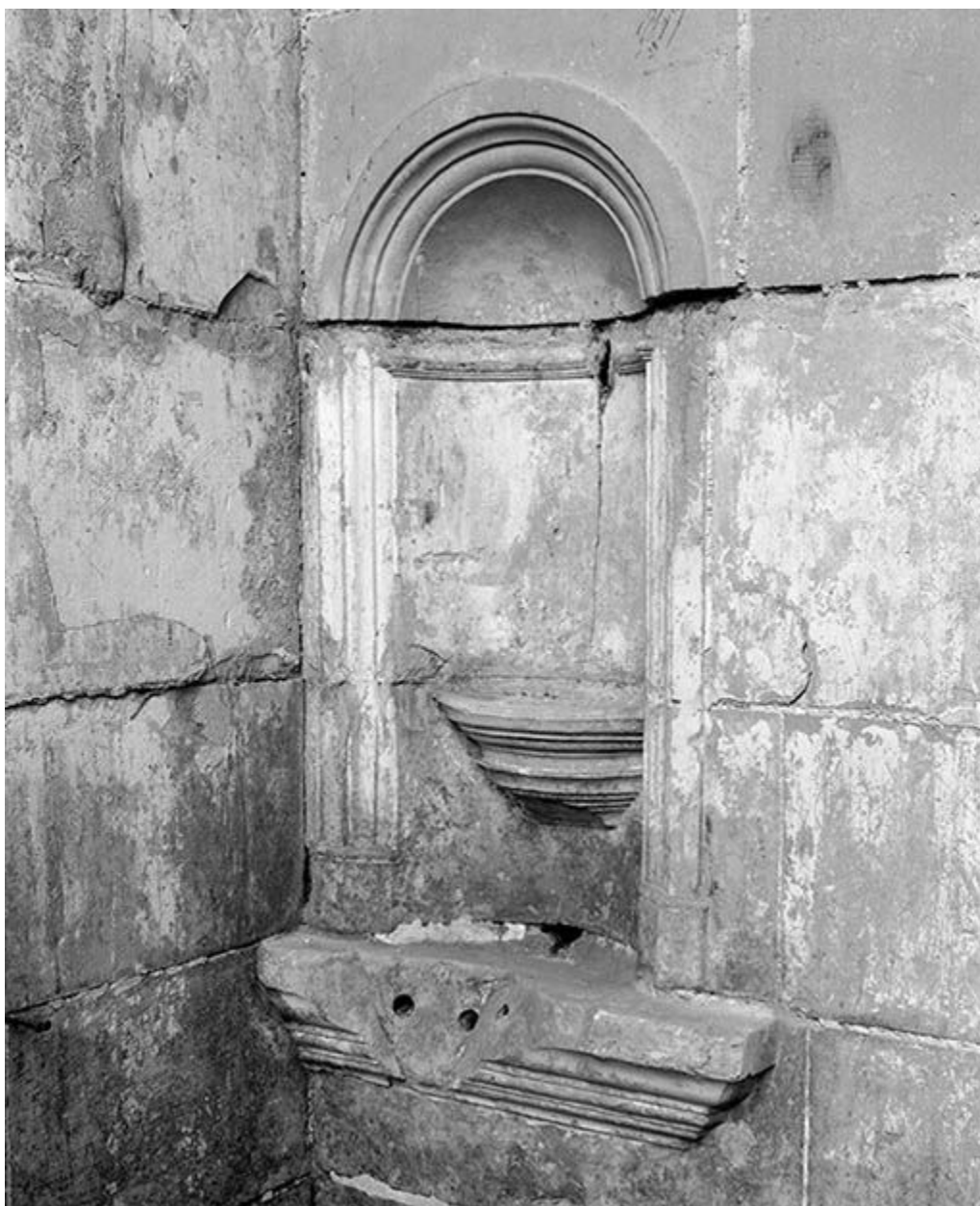
Chapelle sous clocher, lavabo.
