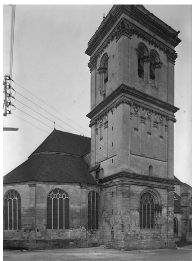
Chevet et tour du clocher. IVR26_19728900452V
