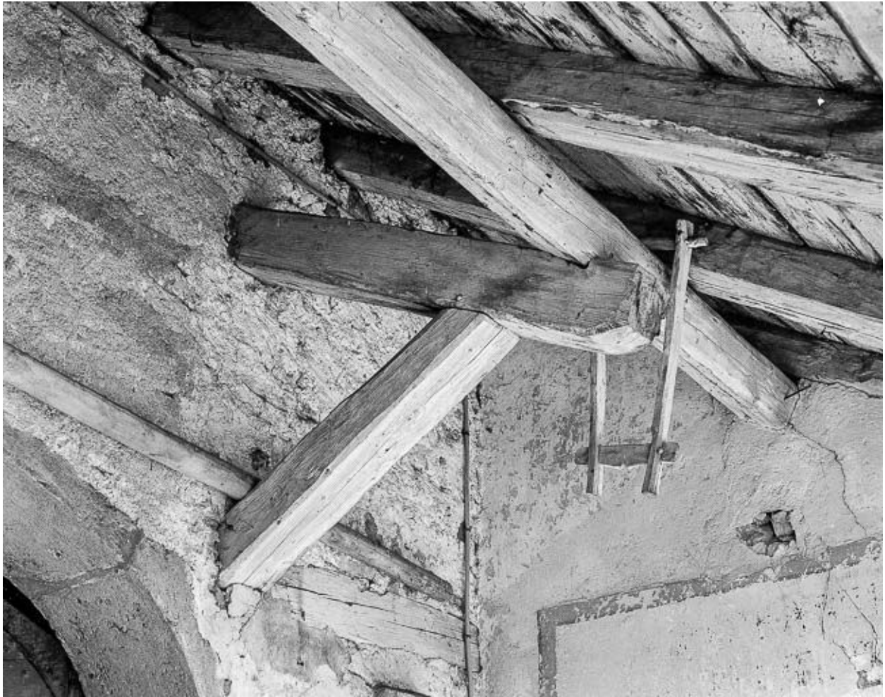
Auvent sur goutterot, côté droit.
