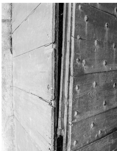
Porte piétonne de la porte de grange. Phot. Dominique Dominguez IVR43_19792500075X
