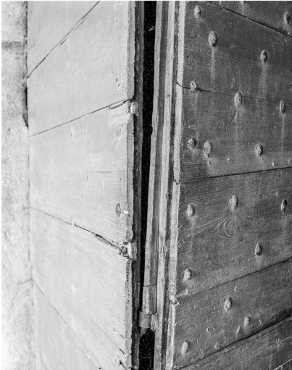
Porte piétonne de la porte de grange.
