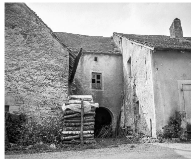
Détail de la façade postérieure. Phot. Yves Sancey IVR43_19777000406X
