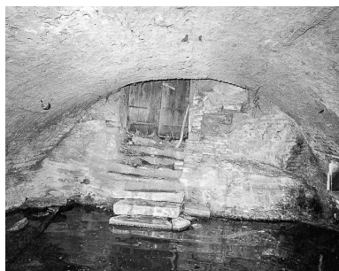
Vue de la cave. Phot. Yves Sancey IVR43_19777000410X
