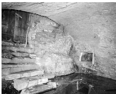
Vue de la cave. Phot. Yves Sancey IVR43_19777000411X
