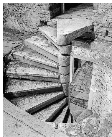
Escalier intérieur. Phot. Yves Sancey IVR43_19777000407X
