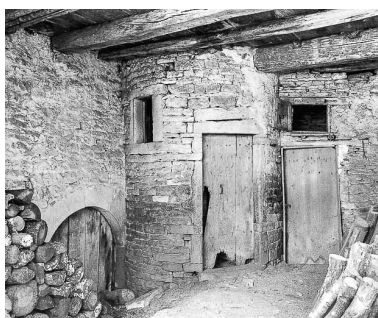
Sortie d'escalier et entrée de cave sous le hangar. Phot. Yves Sancey IVR43_19777000409X
