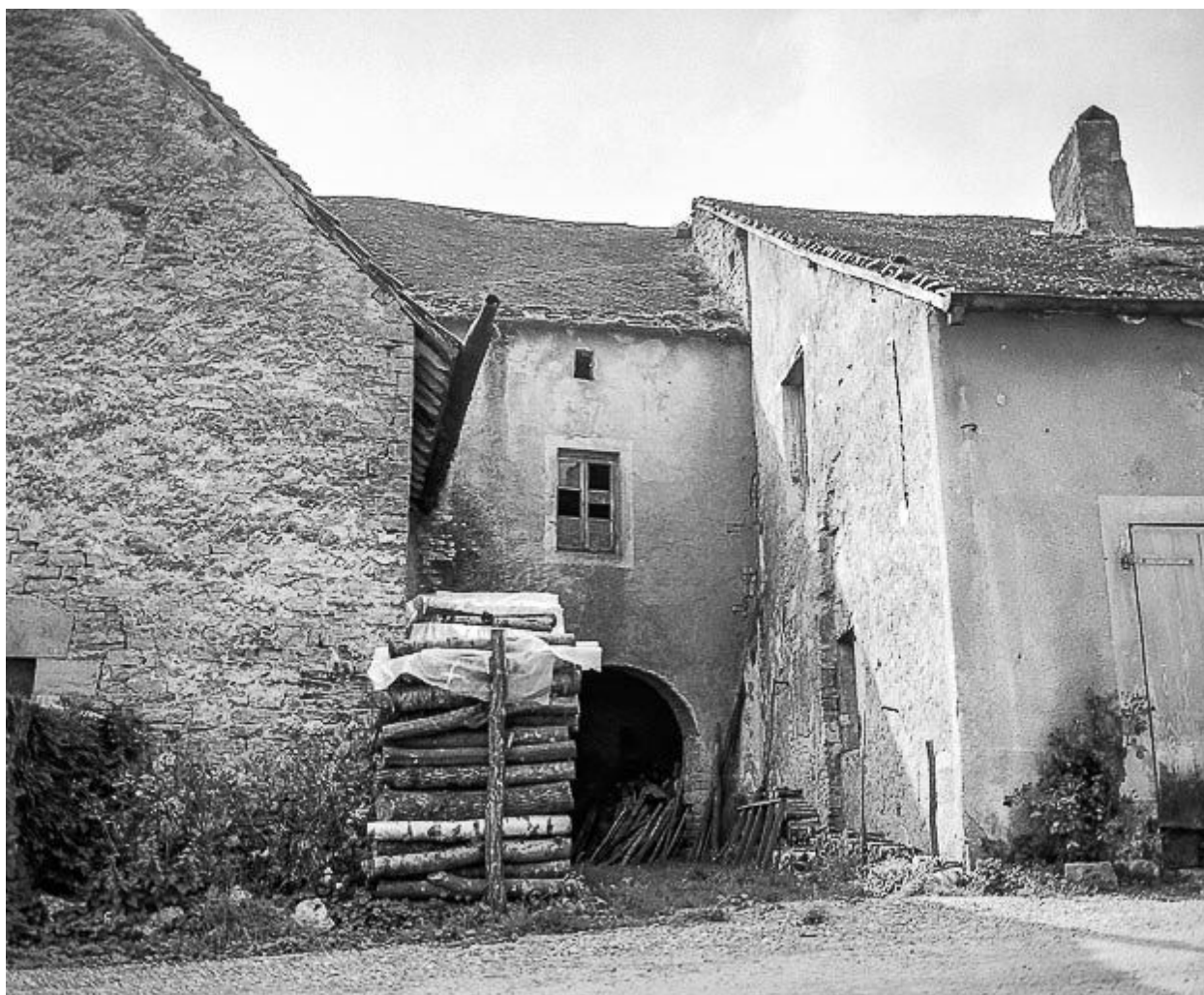
Détail de la façade postérieure.
