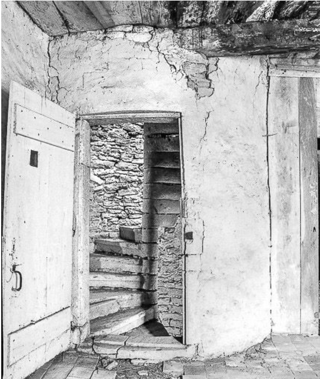
Tourelle d'escalier au niveau du 1er étage.
