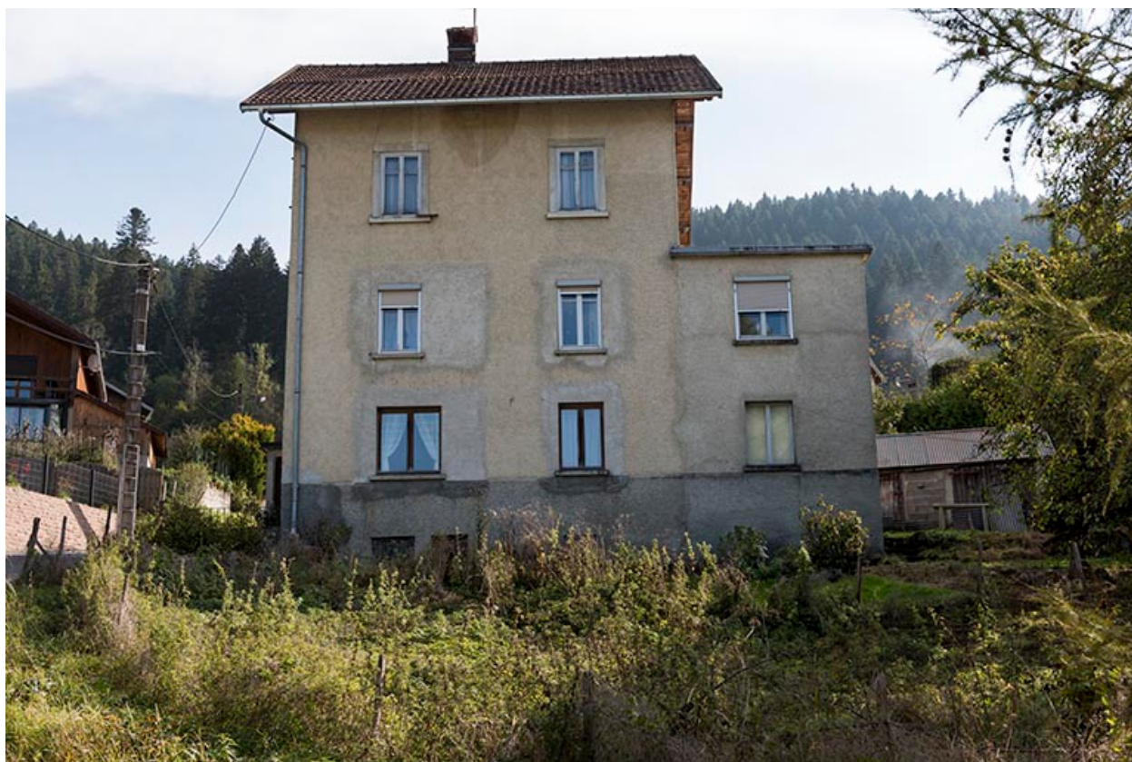
Façade latérale droite, vue en contre-plongée.
