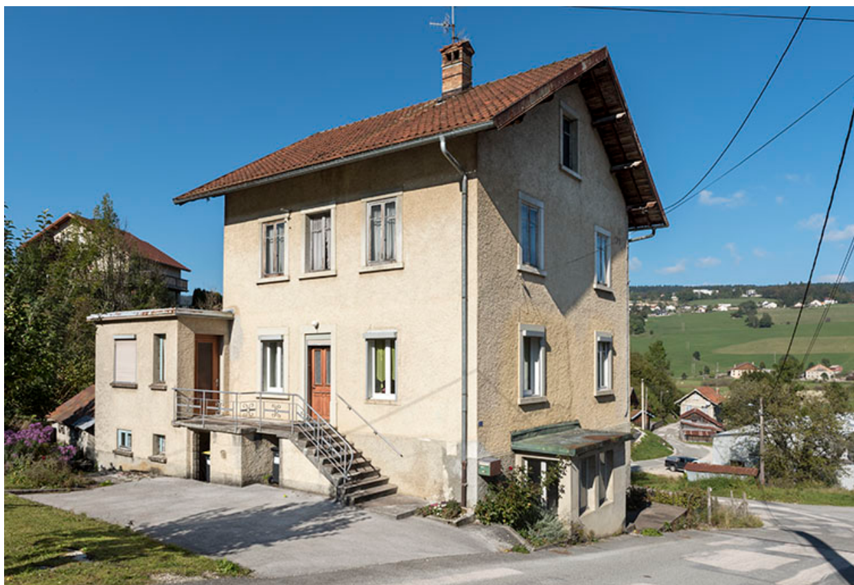
Façades antérieure et latérale gauche.
