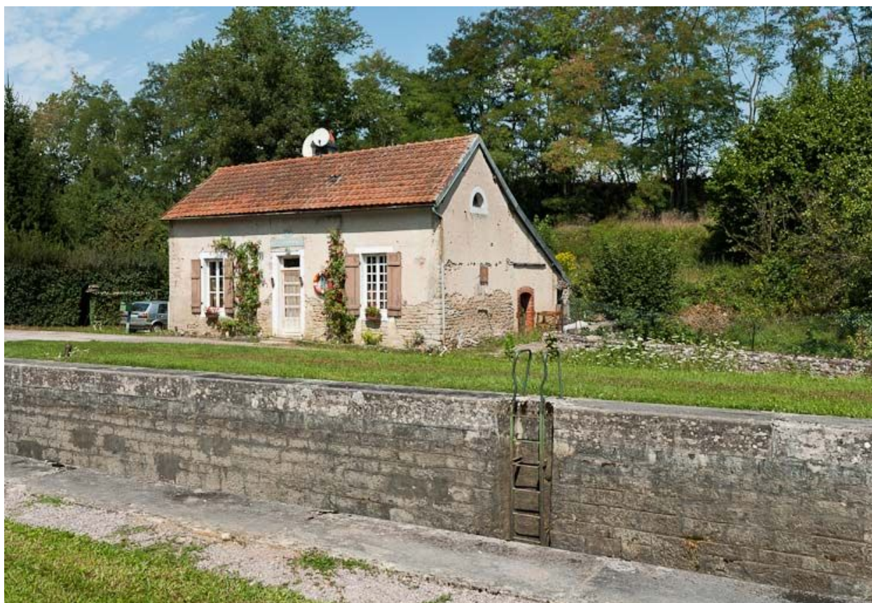
Vue de 3/4 de la maison éclusière.
