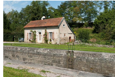
Vue de 3/4 de la maison éclusière. Phot. Pierre-Marie Barbe-Richaud IVR26_20112103461NUC4AQ
