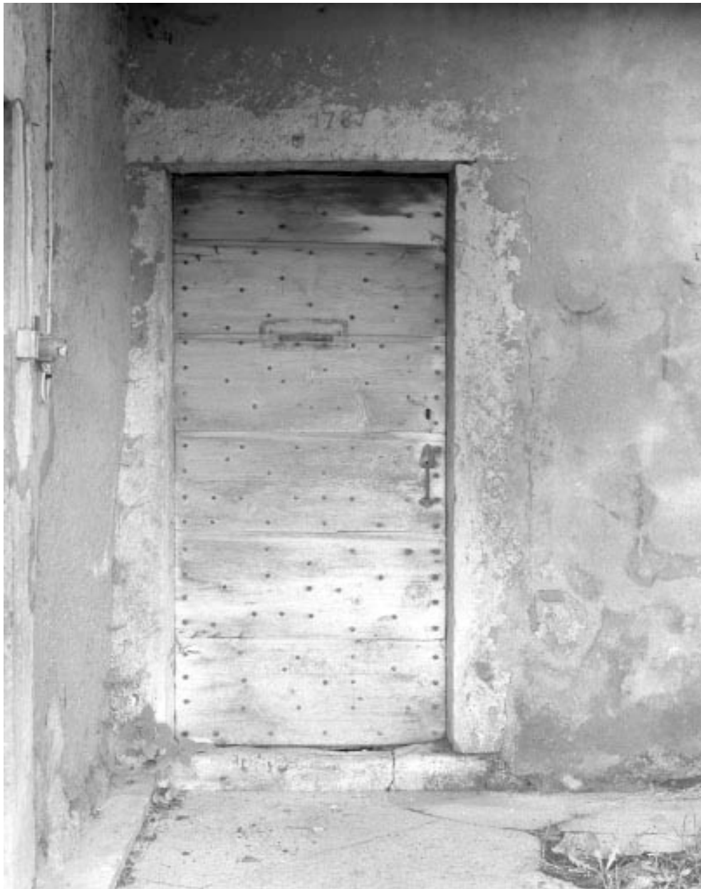
Porte d'accès au logis du rez-de-chaussée.
