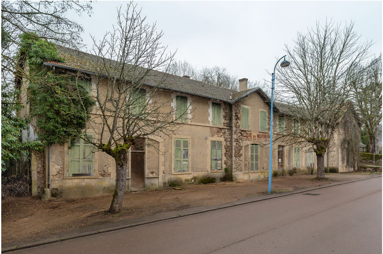
Façade principale, vue depuis le sud-ouest.
