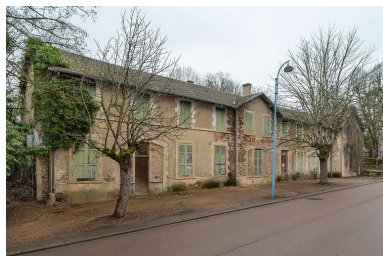
Façade principale, vue depuis le sud-ouest.
