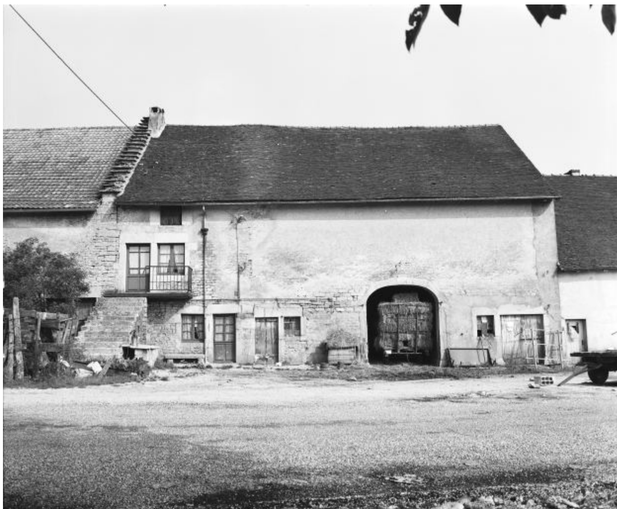
Ferme située rue de la Suisse : façade antérieure.
