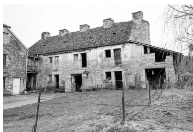
Logement d'ouvriers sud en 1979. Phot. J. Dumont IVR43_19792501141Z
