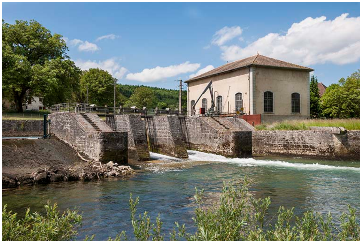
La centrale hydroélectrique et son déversoir.
