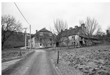
Logements d'ouvriers depuis l'ouest en 1979. Phot. J. Dumont IVR43_19792501142Z
