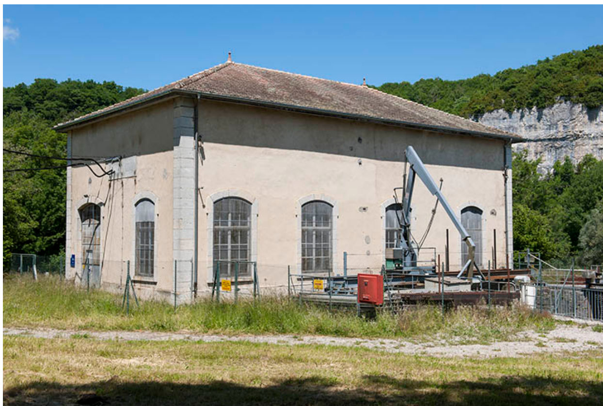
La centrale hydroélectrique vue de trois quarts.
