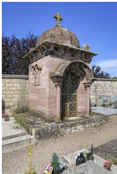
Vue d'ensemble. Phot. Fabien Dufoulon IVR43_20217000428NUC2A
