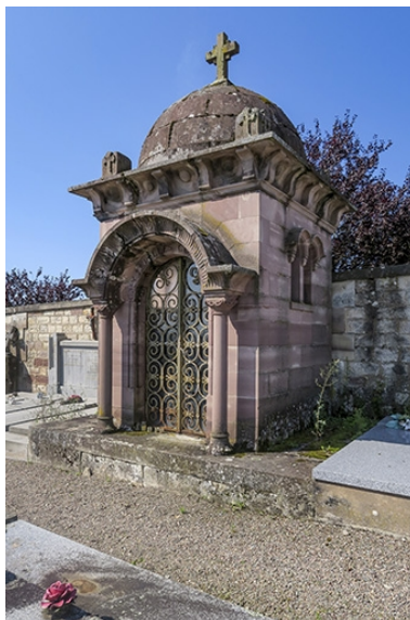
Vue d'ensemble. Phot. Fabien Dufoulon IVR43_20217000427NUC2A
