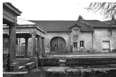
Ferme située rue Sainte-Anne. Phot. Yves Sancey IVR43_19817000026X
