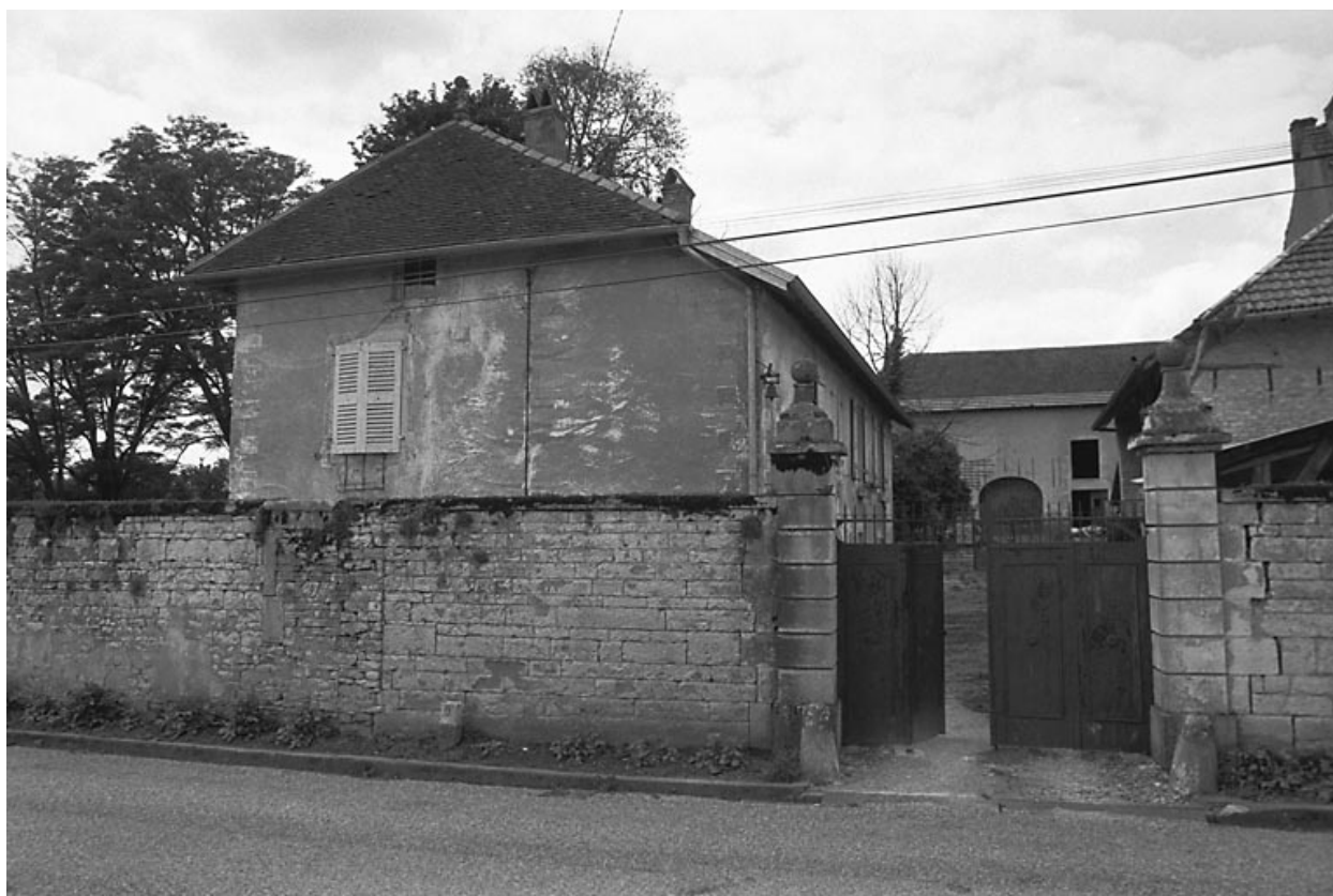
Vue d'ensemble depuis la rue.
