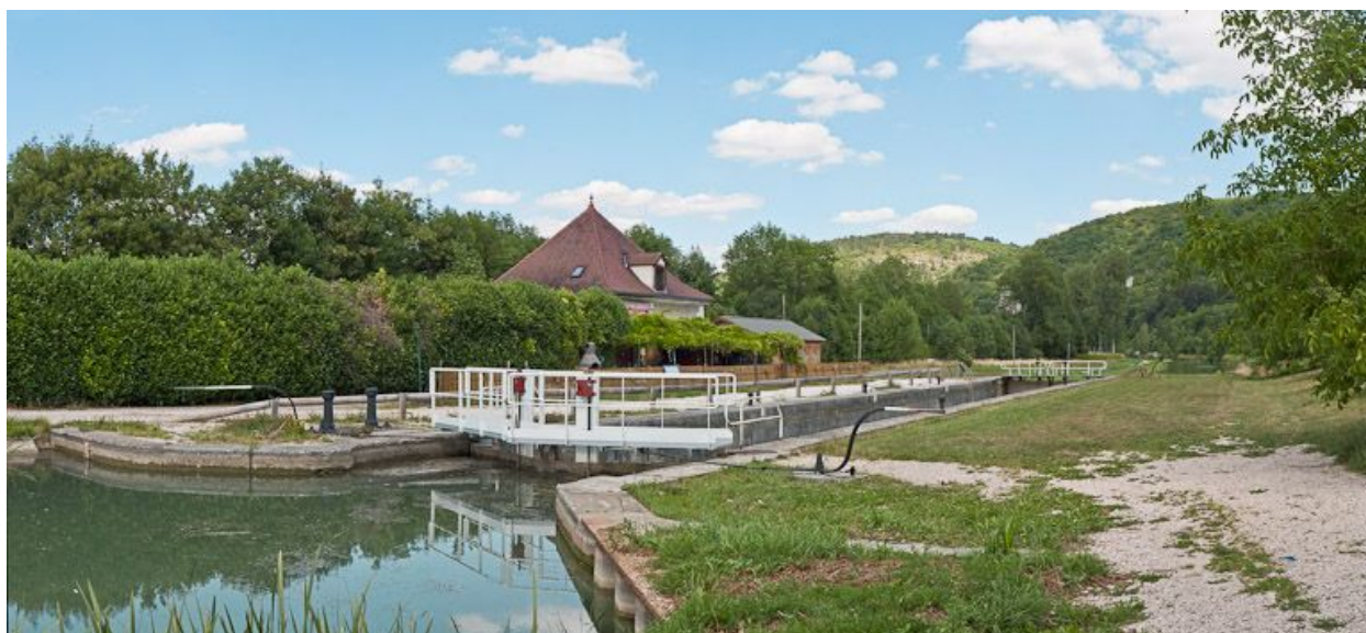
Vue d'ensemble du site d'écluse.
