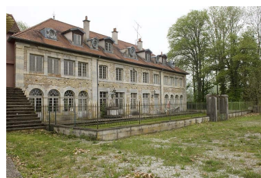
Logement patronal. Vue de trois quarts. Phot. Jérôme Mongreville IVR43_20067000236NUCA
