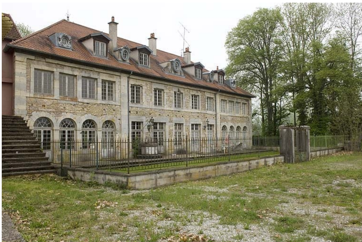
Logement patronal. Vue de trois quarts.
