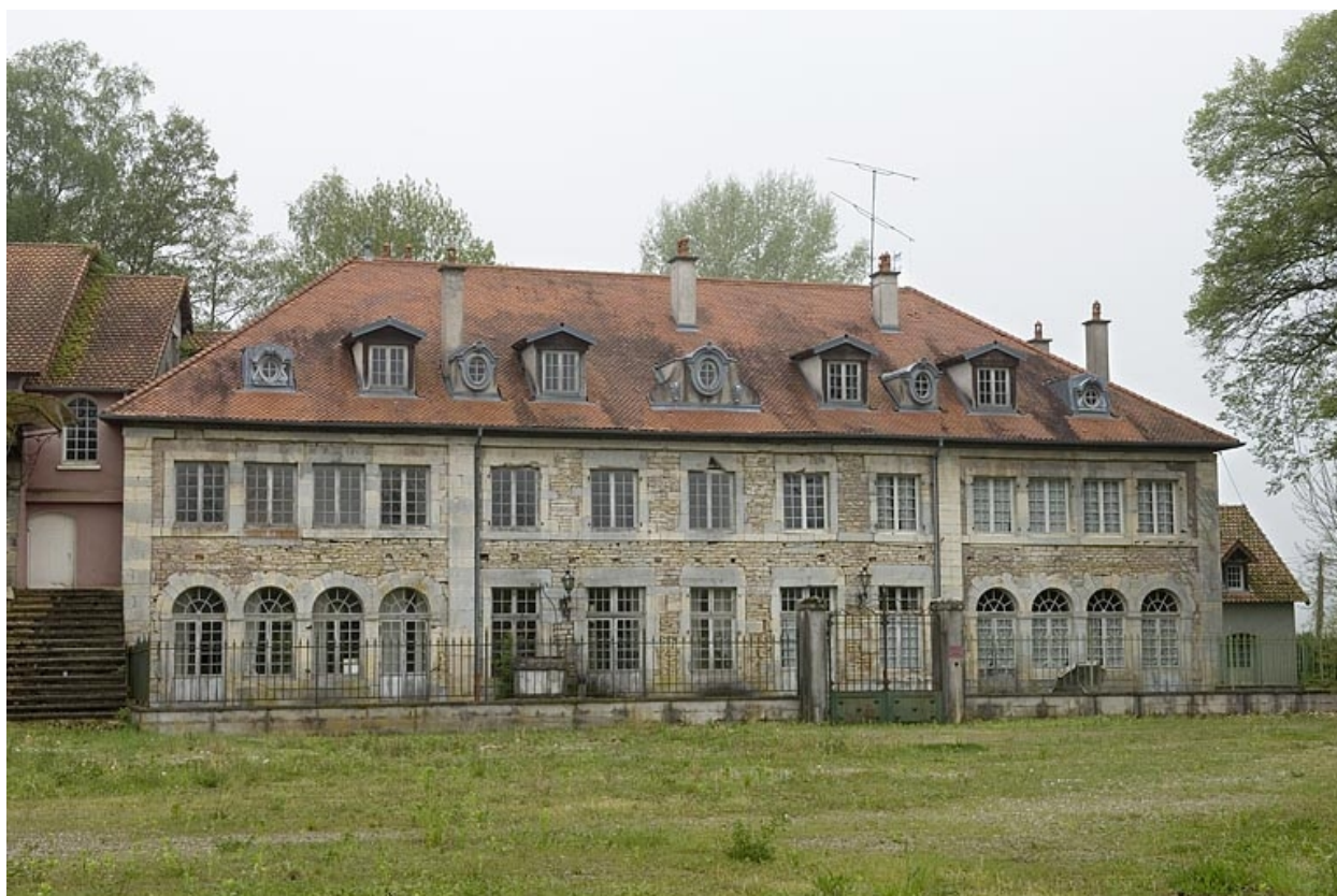
Logement patronal. Façade antérieure.
