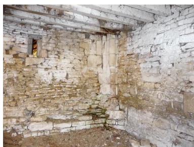
Chapelle, corps postérieur : vue de l'angle sud-ouest. Phot. Cécile Lestienne, Phot. Virginie Malherbe IVR26_20128900296NUC2A
