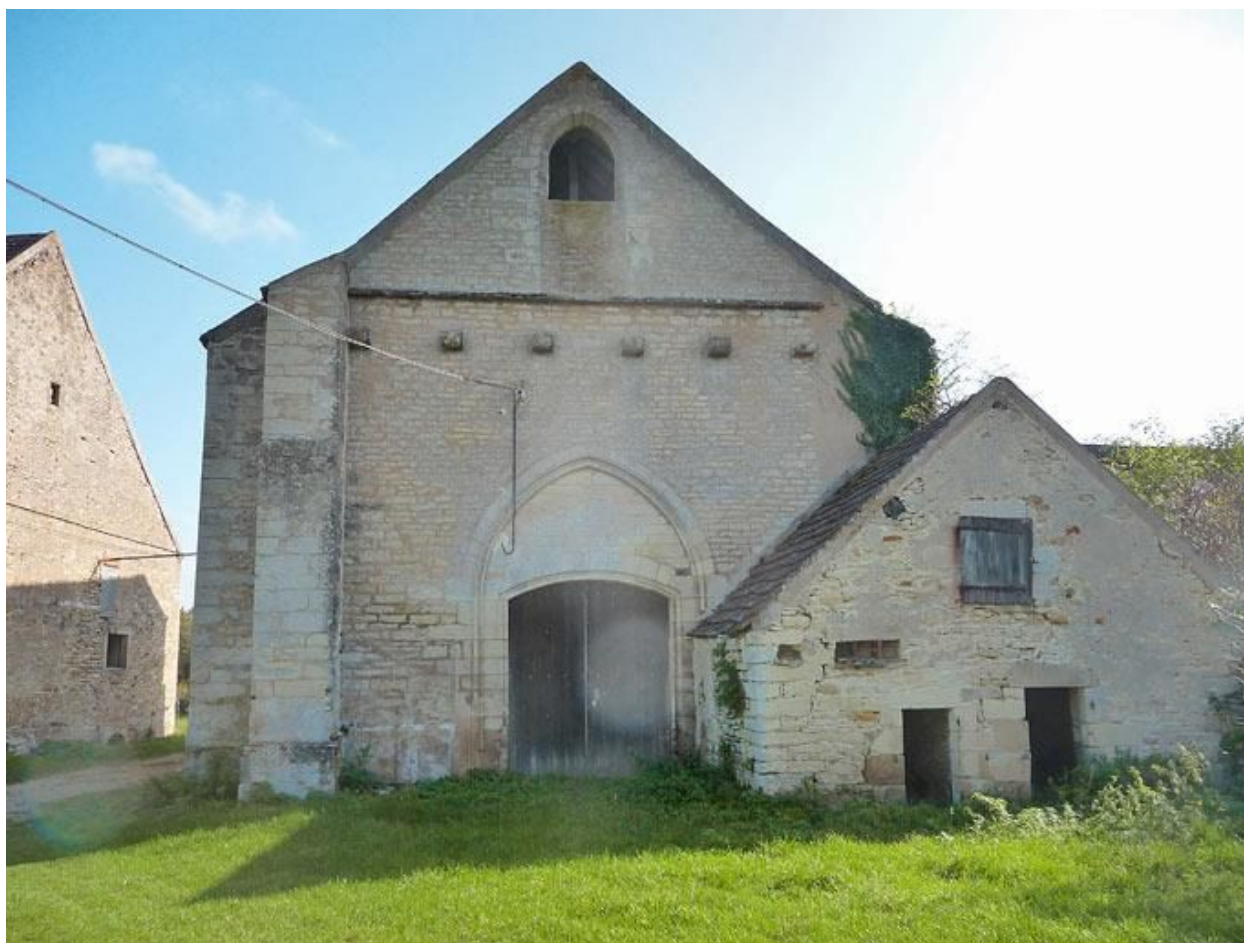
Façade de la chapelle et petite dépendance.
