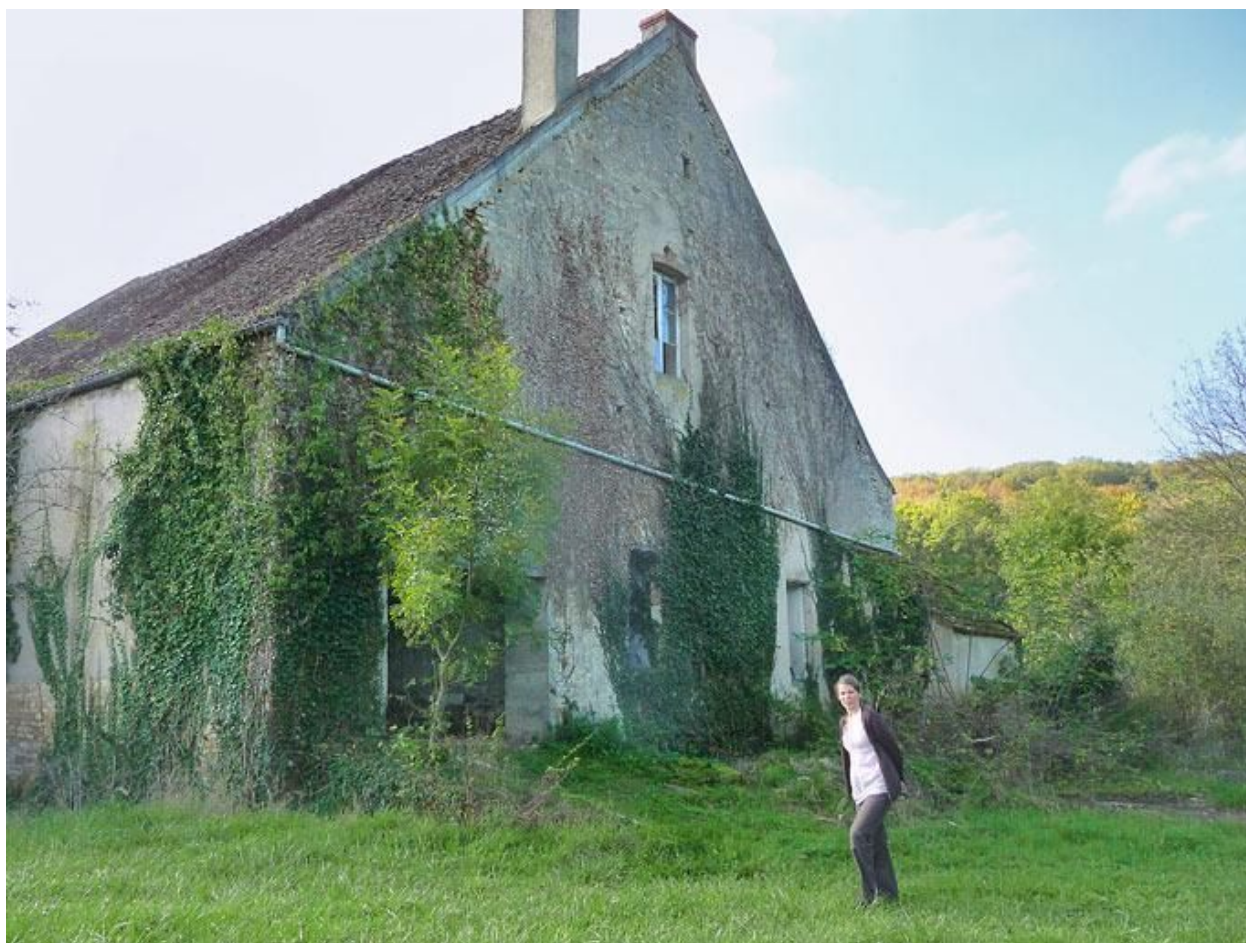
Mur gauche de la grange.
