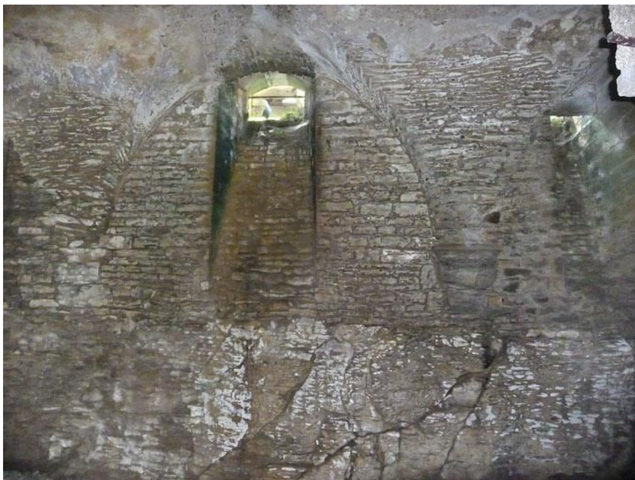
Cave sous la grange : soubassement rocheux, soulard et culots.
