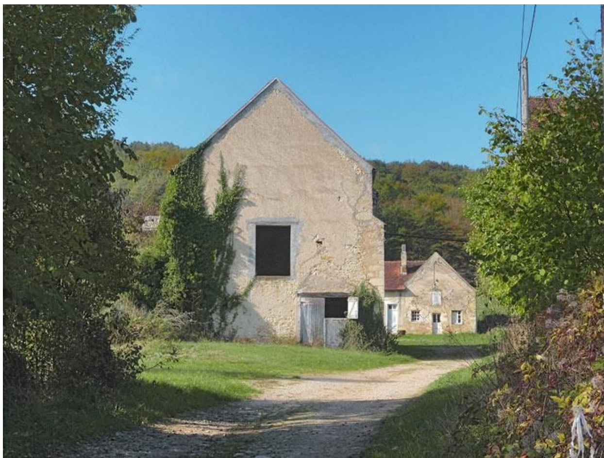
Mur postérieur de la chapelle.
