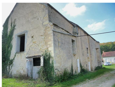
Murs postérieur et gauche de la chapelle. Phot. Cécile Lestienne, Phot. Virginie Malherbe IVR26_20128900283NUC2A
