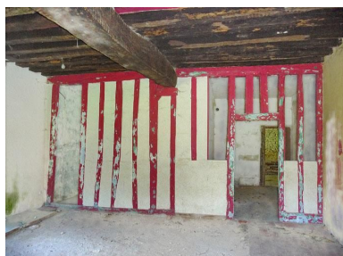
Première pièce du logis du rez-de-chaussée de la grange, cloison en pans de bois. Phot. Cécile Lestienne, Phot. Virginie Malherbe IVR26_20128900292NUC2A
