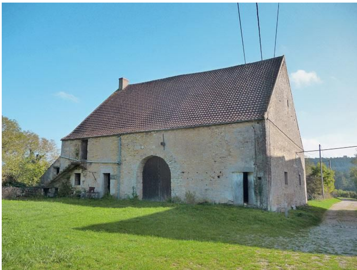
Façade de la grange.
