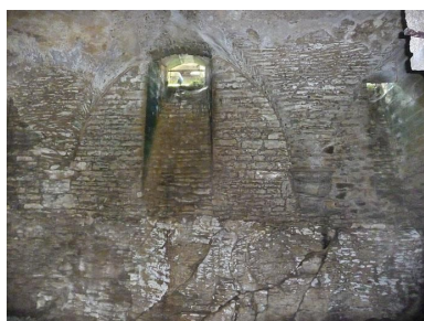
Cave sous la grange : soubassement rocheux, soupirail et culots. Phot. Cécile Lestienne, Phot. Virginie Malherbe IVR26_20128900304NUC2A
