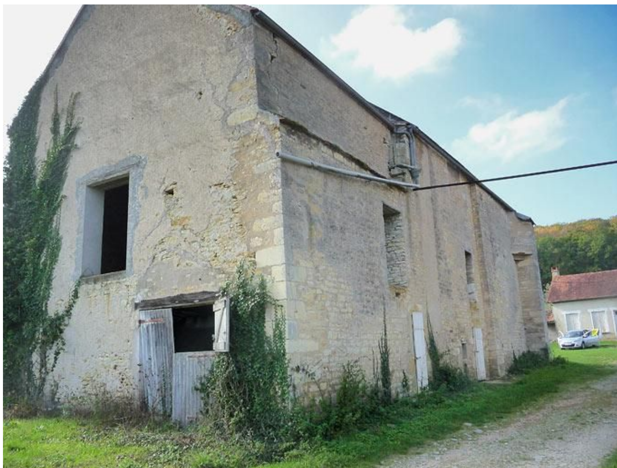
Murs postérieur et gauche de la chapelle.
