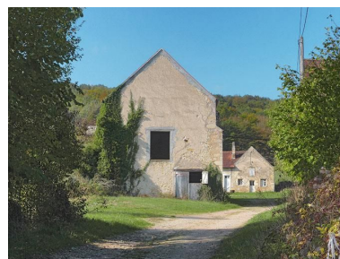
Mur postérieur de la chapelle. Phot. Cécile Lestienne, Phot. Virginie Malherbe IVR26_20128900280NUC2A
