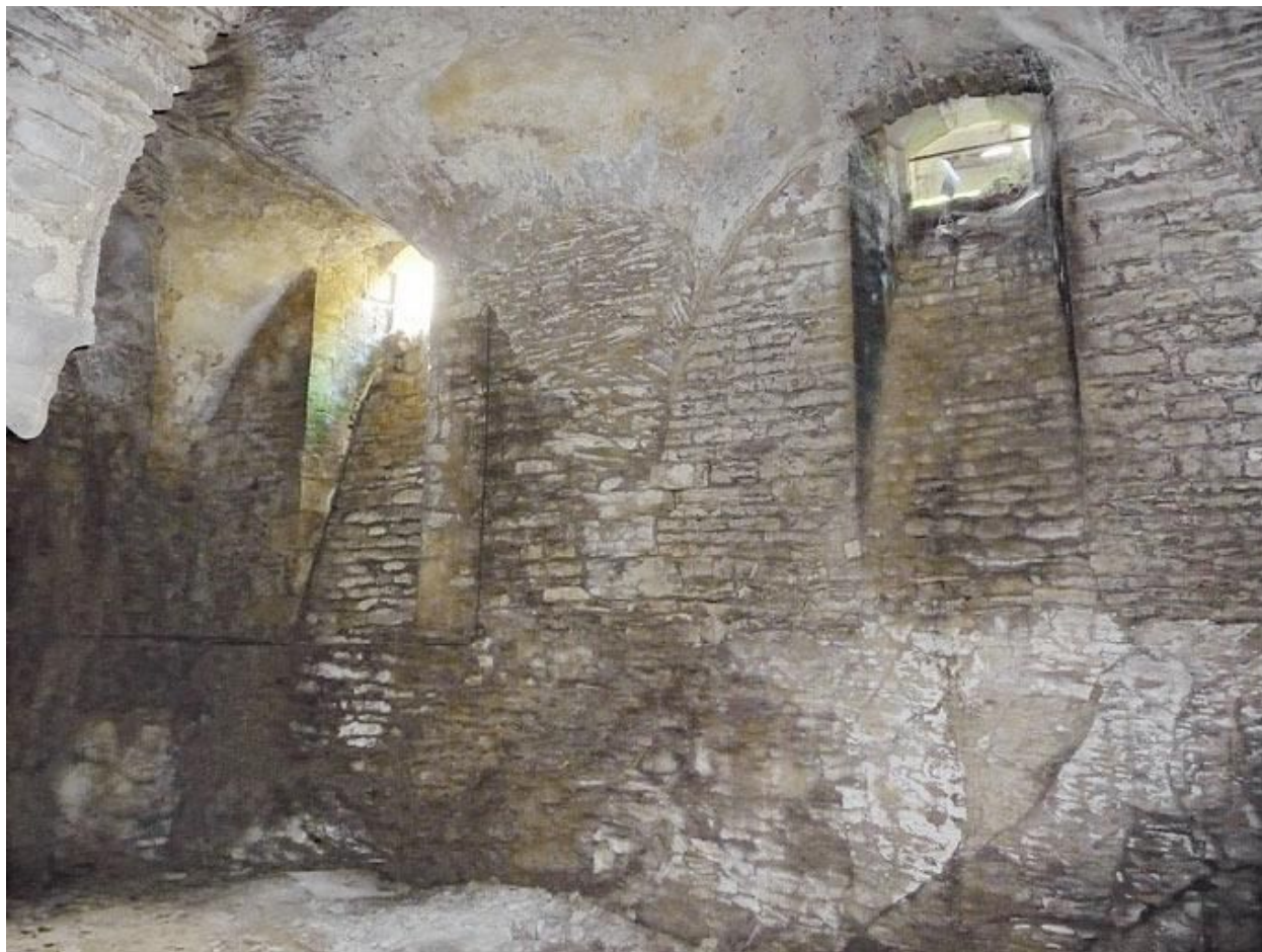
Cave sous la grange : voûte et soupiraux.
