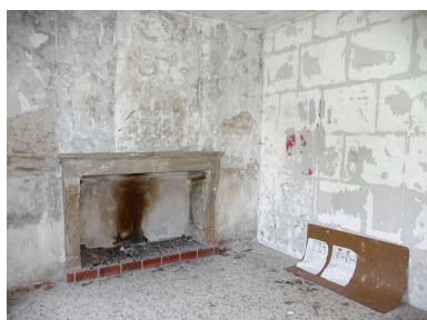
Deuxième pièce du logis du rez-de-chaussée de la grange. Phot. Cécile Lestienne, Phot. Virginie Malherbe IVR26_20128900293NUC2A
