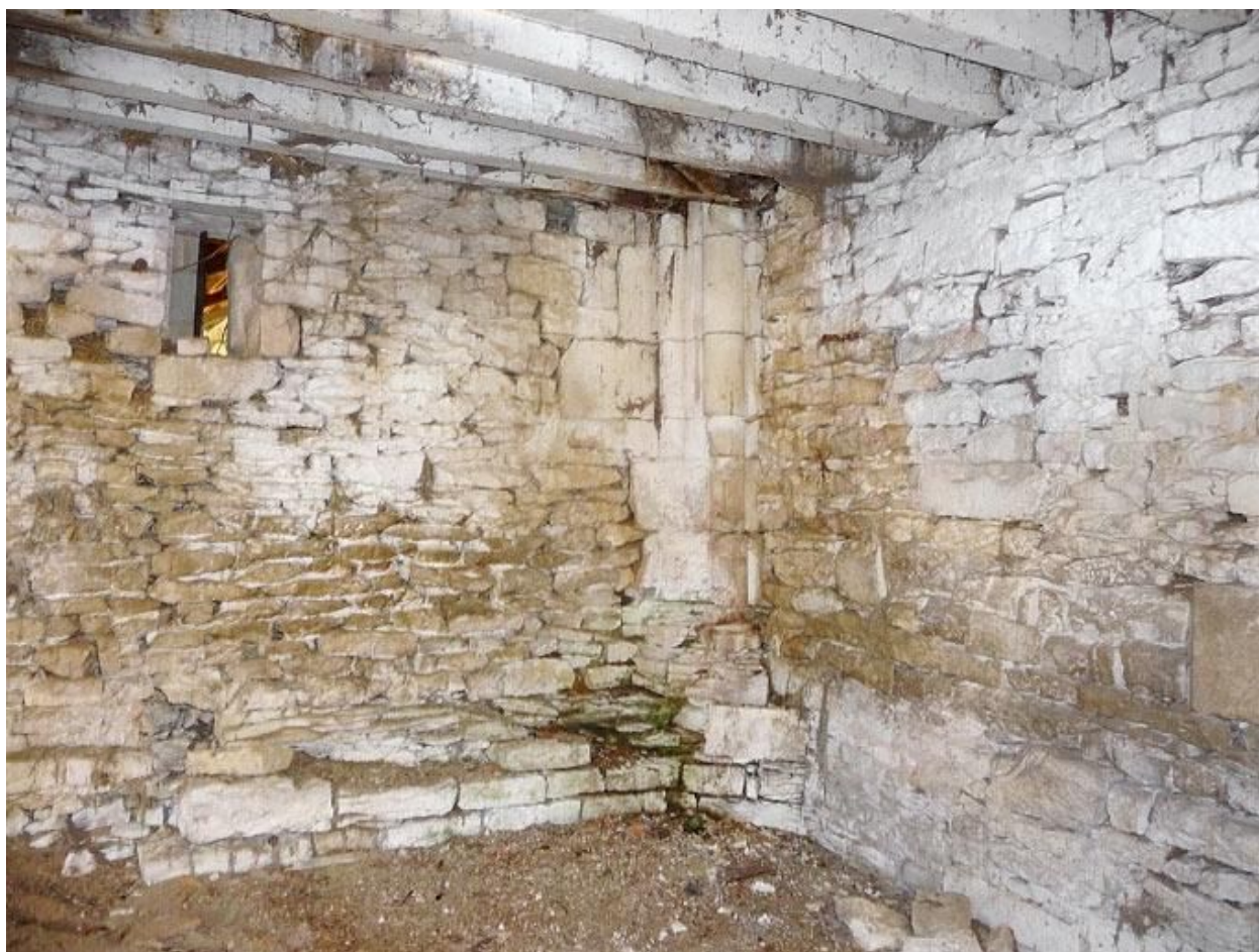
Chapelle, corps postérieur : vue de l'angle sud-ouest.
