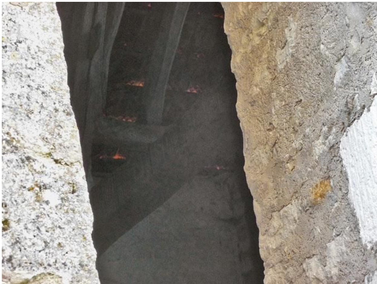
Chapelle, corps antérieur : détail de la charpente.
