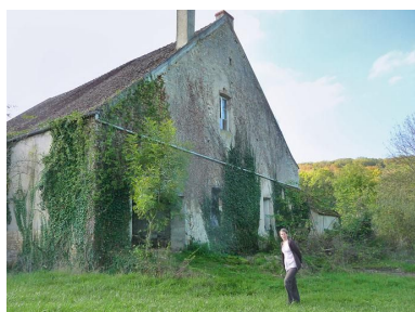
Mur gauche de la grange. Phot. Cécile Lestienne, Phot. Virginie Malherbe IVR26_20128900284NUC2A
