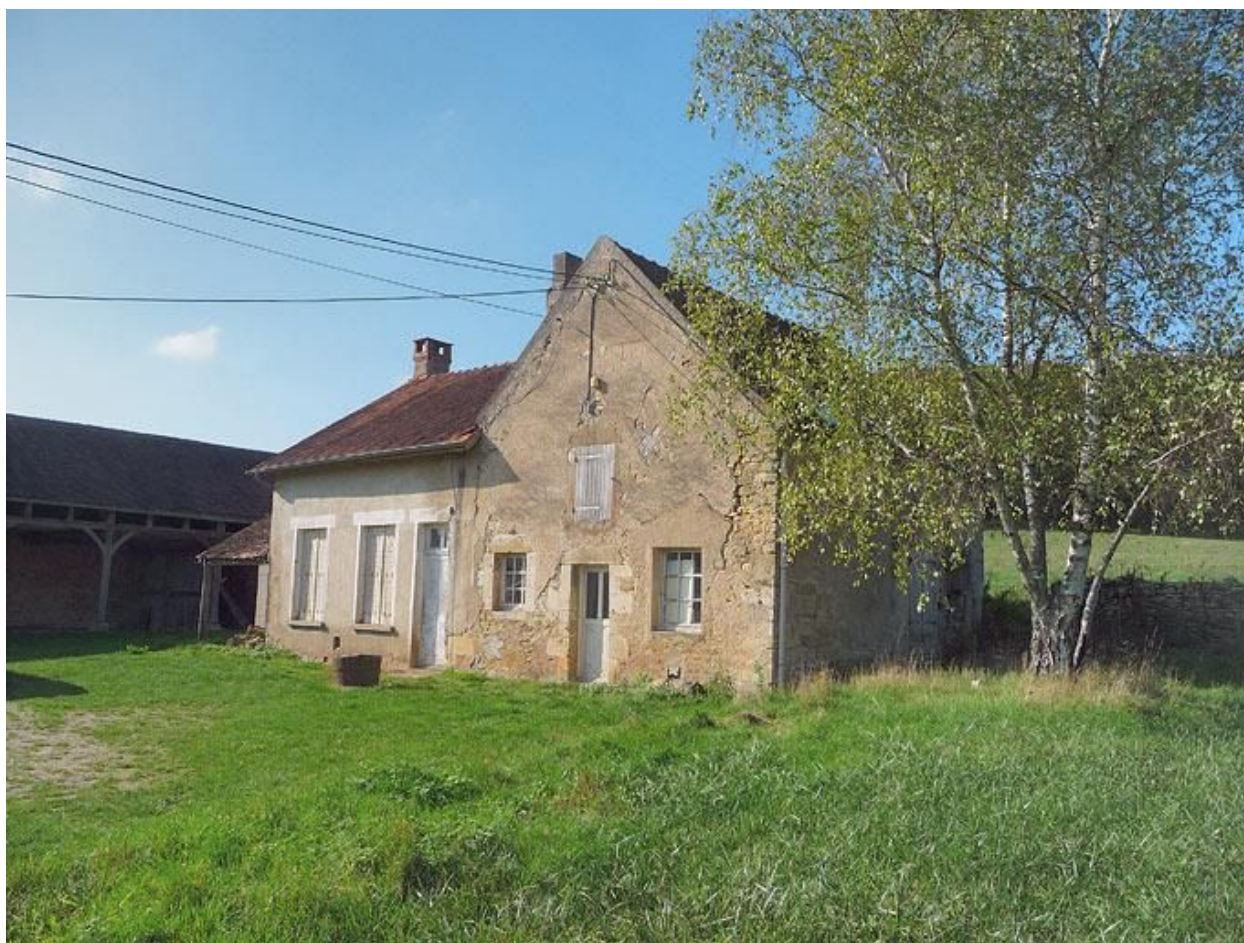
Maison d'habitation de la ferme.
