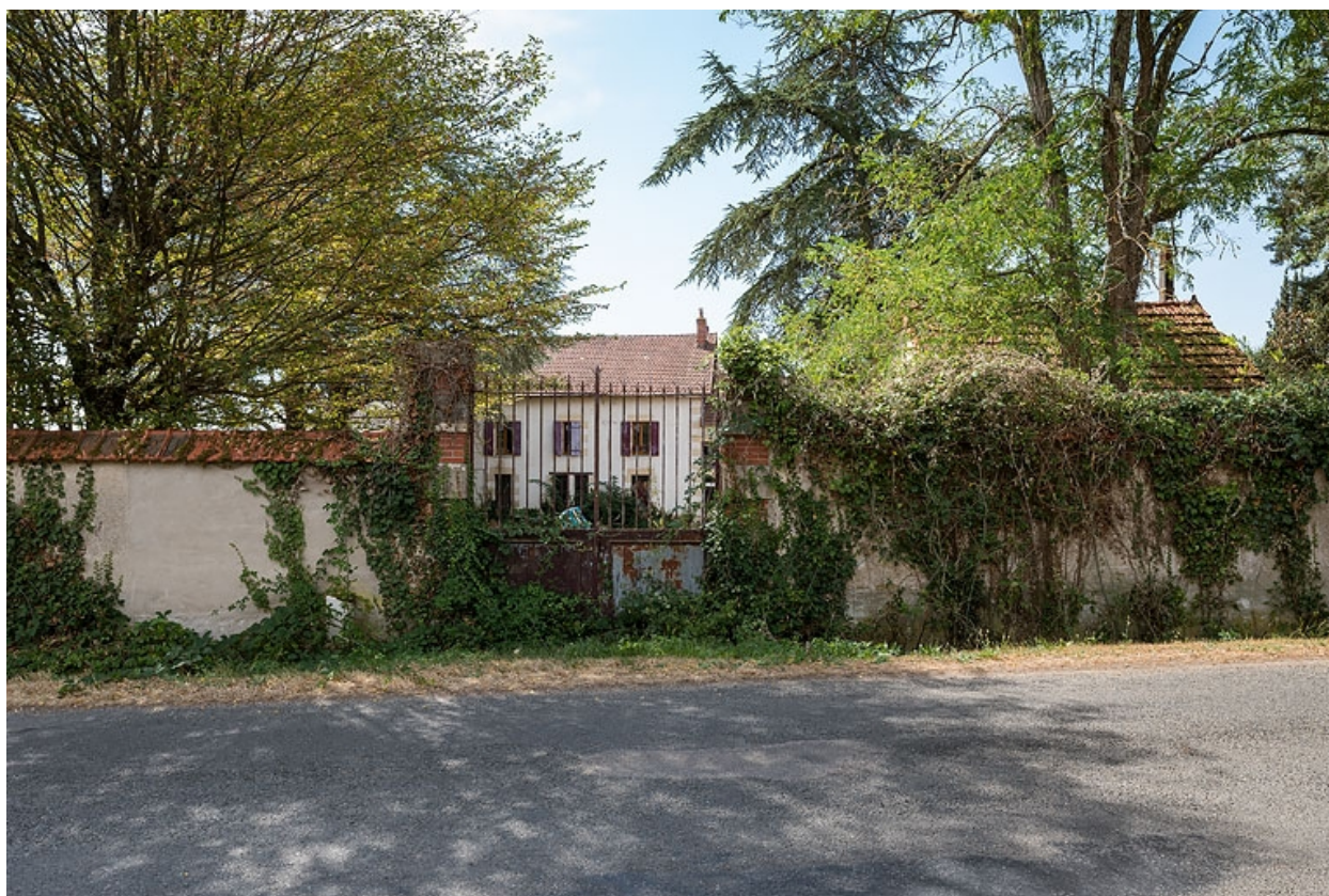
Portail d'entrée sur la rue des Fonts-Bouillants.
