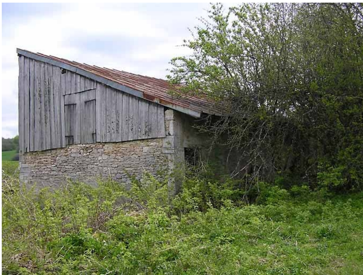
Vue générale du pignon nord-est.
