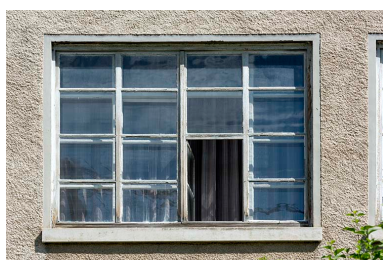
Façade sud : fenêtre d'atelier.
