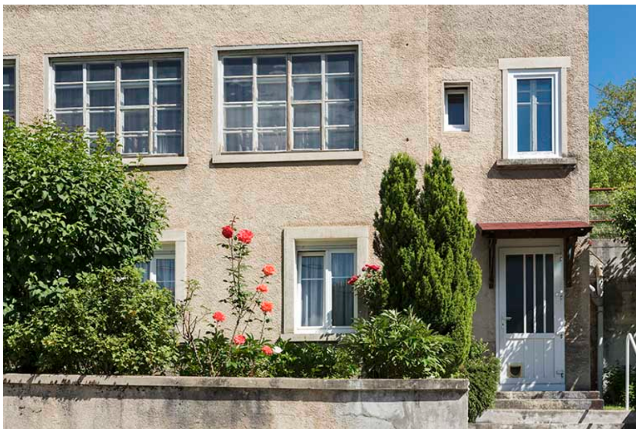
Façade sud : entrée à droite.
