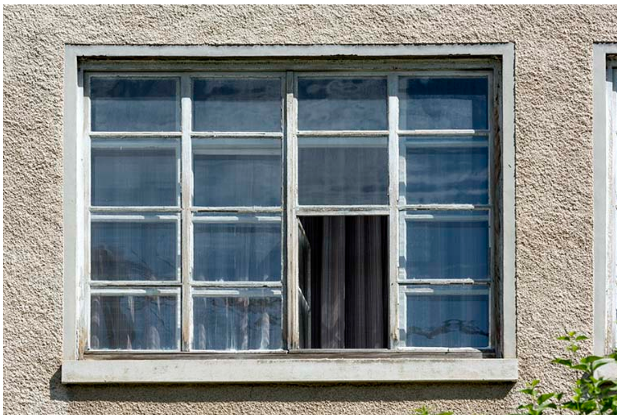
Façade sud : fenêtre d'atelier.
