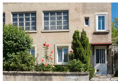
Façade sud : entrée à droite.
