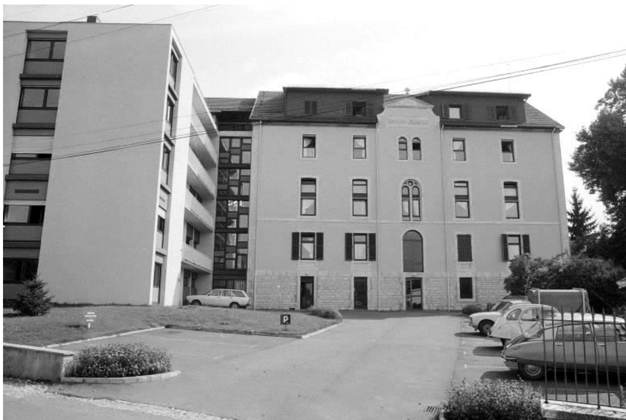
Façade antérieure et annexe.
