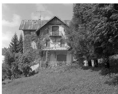
Façade sud-est. Phot. Jérôme Mongreville IVR43_20003900426X
