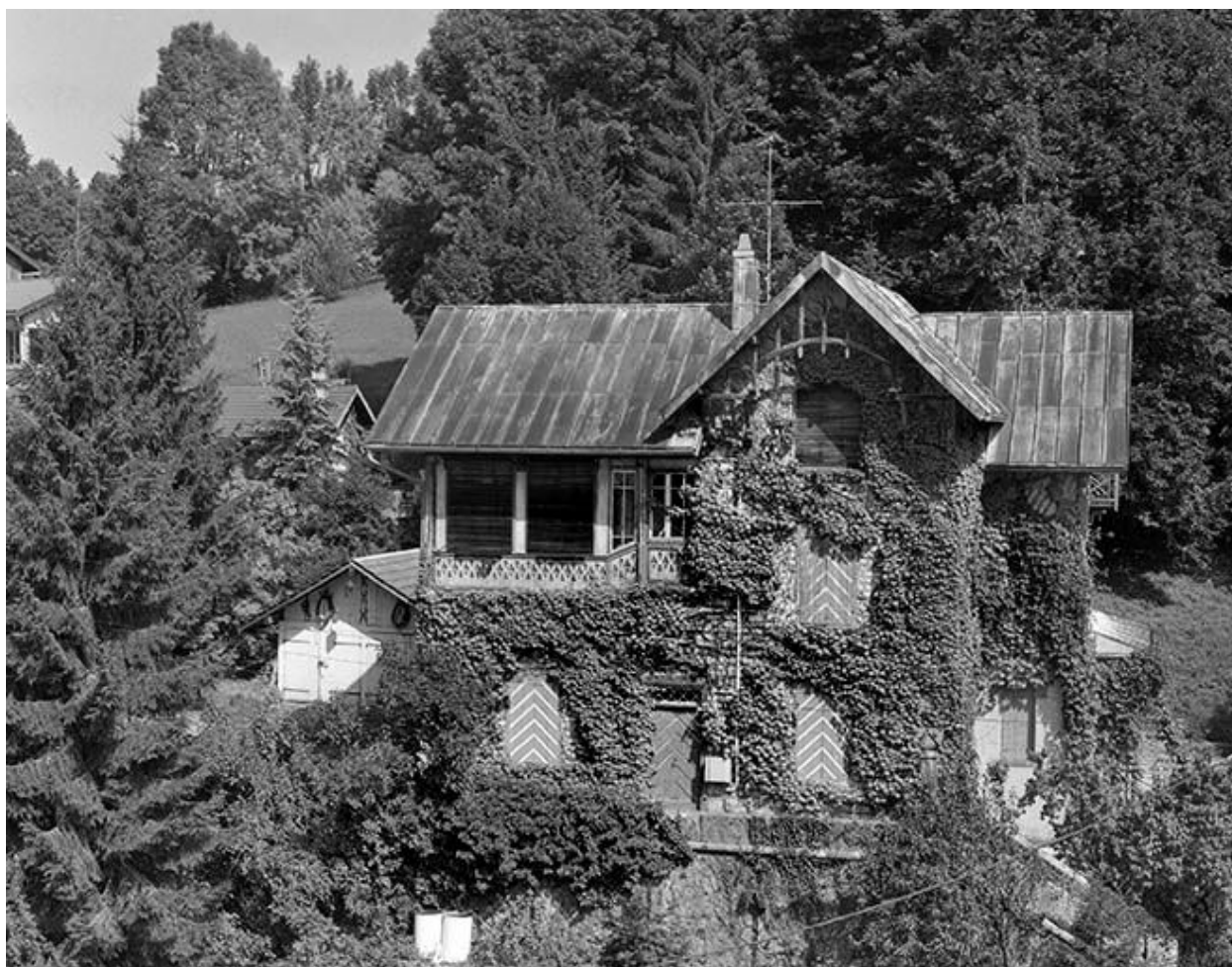
Vue éloignée de la façade sud-ouest.
