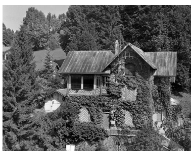
Vue éloignée de la façade sud-ouest. Phot. Jérôme Mongreville IVR43_20003900427X
