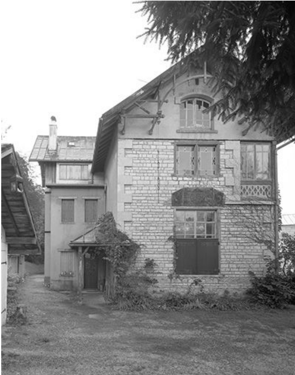
Vue rapprochée de la façade nord-ouest.
