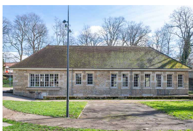
Vue depuis l'ouest.
