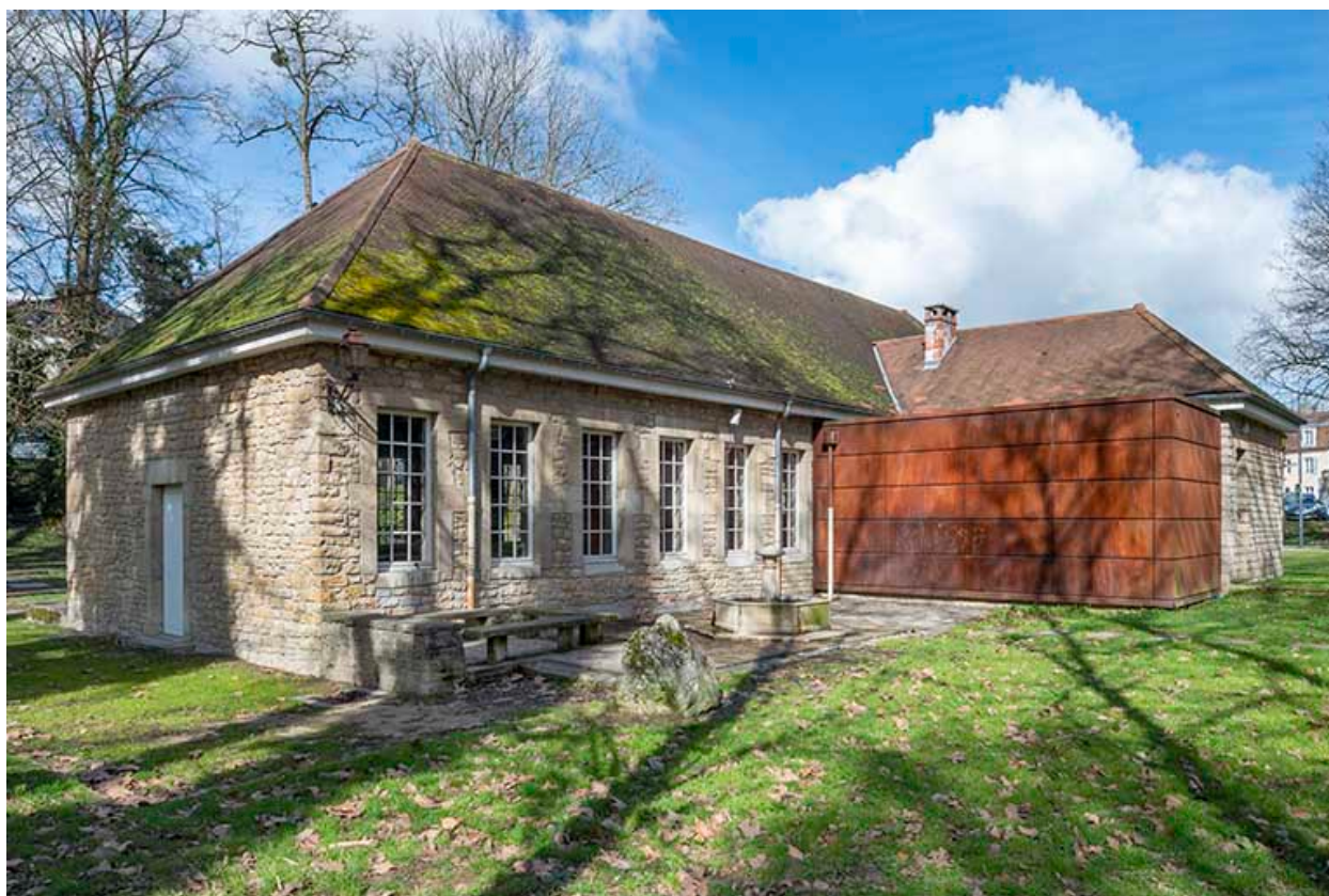
Vue depuis le sud-est.
