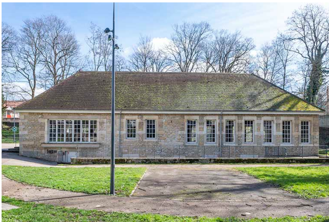
Vue depuis l'ouest.
